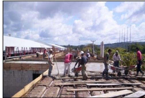
Fotografía No 10: Armado de Losas.
