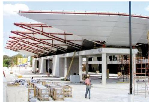
Fotografía No 17. Recubrimiento de estructuras con aluminio extruido.
