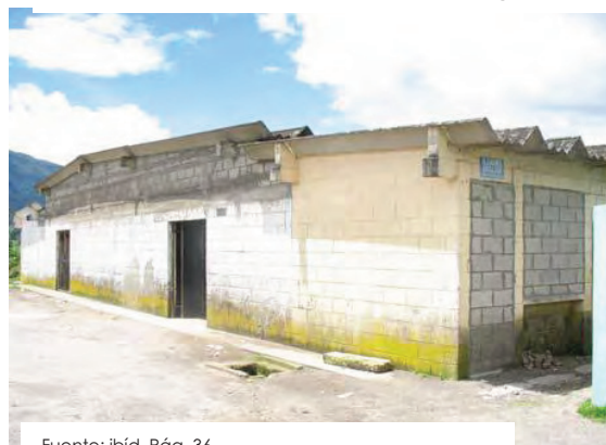
Fotografía 5 Municipio de Esquipulas Palo Gordo, San Marcos Vista exterior del mercado Municipal
