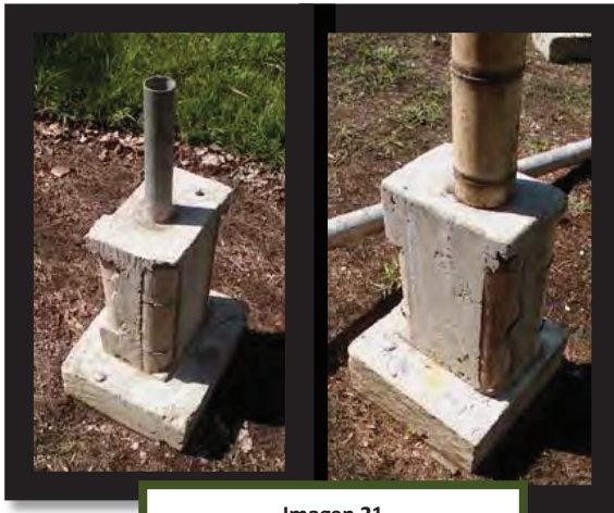
Imagen 21 Columna de bambú empotrada con 1 poste.
