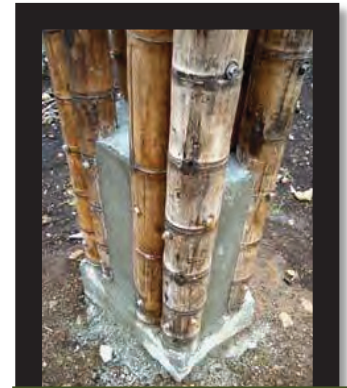
Imagen 20 Columna de bambú empotrada con 4 postes.
