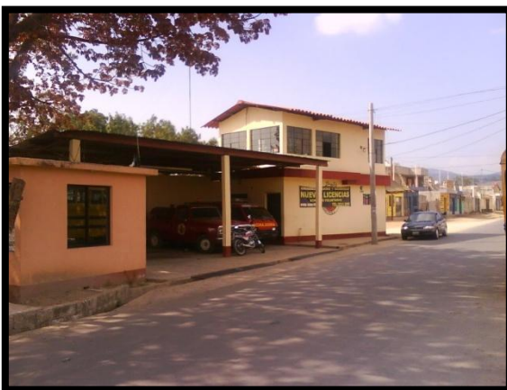
Estación de Bomberos Municipales
