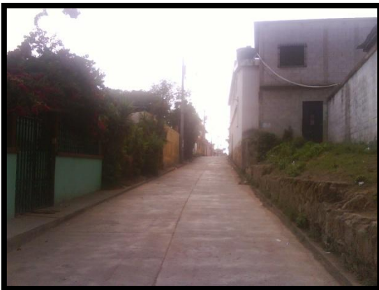
Calle de concreto 2ª Av. Fuente: propia
