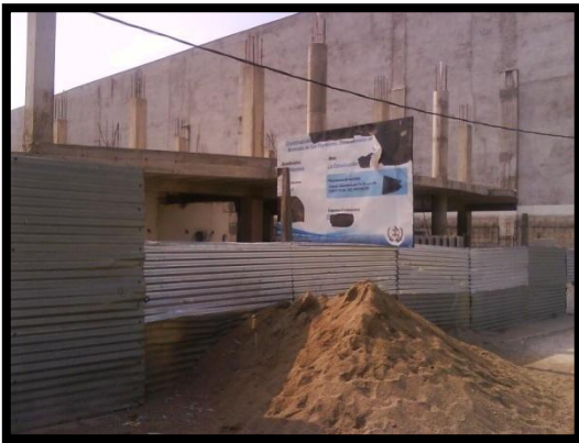
Construcción nuevo Centro de Salud Fuente: propia
