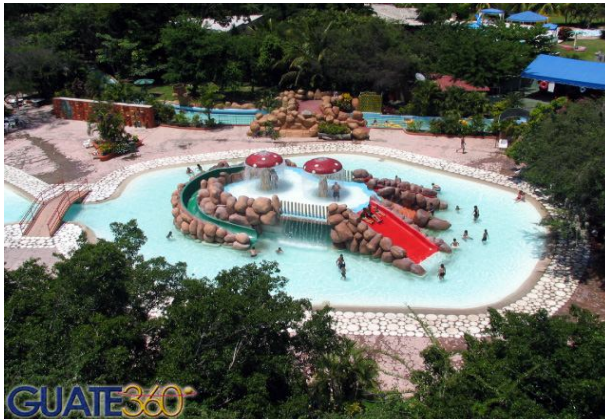
FOTOGRAFIA No.13 (Vista Aérea del modulo de piscinas y hongos llorones). ( www.guate360.com )
