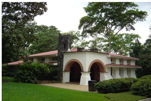
FOTOGRAFIA No.5 (Vista de Conjunto exterior del Salón de Conferencias). ( www.guate360.com )
