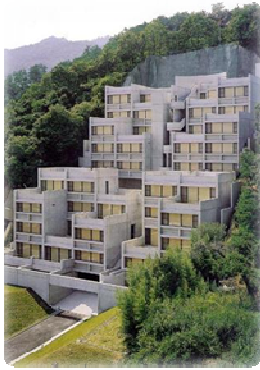
(PGE I . 7) Casa rokko - Tadao Ando Viviendas rokko housing, en kobe
