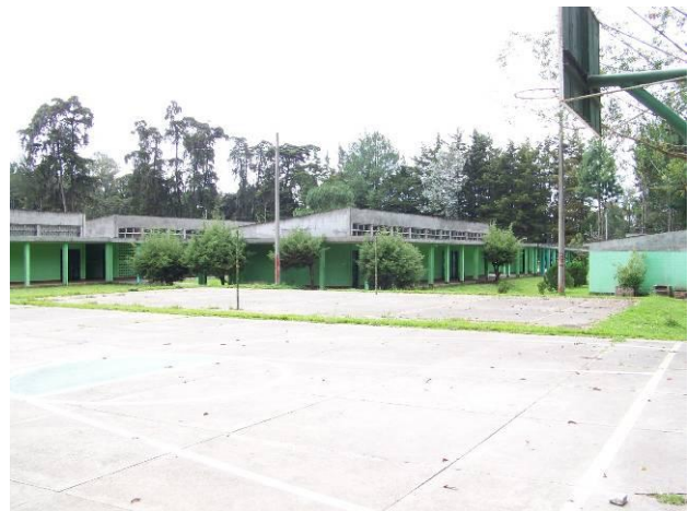
Fotografía 42. Canchas deportivas, al fondo módulos de aulas.
