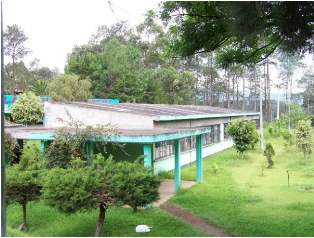
Fotografía 37. Módulo de Administración.
