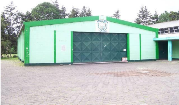
Fotografía 39. Salón de usos múltiples y cocina a un costado del mismo.
