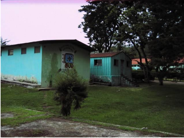
Fotografía 43. Bodegas que funcionan como aulas de la Escuela Normal de Educación Bilingüe.
