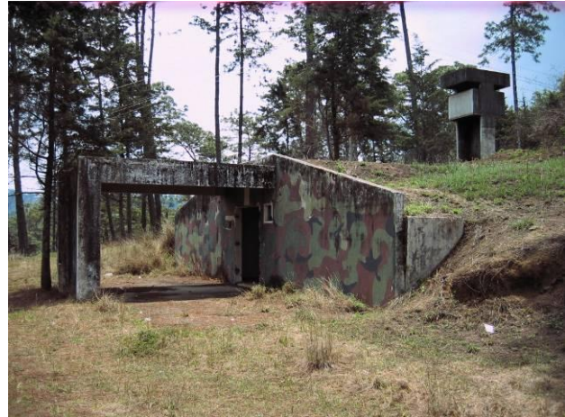
Fotografía 1. Evidencia de la ocupación militar en la escuela, en este caso uno de los varios "Bunkers" existentes.
