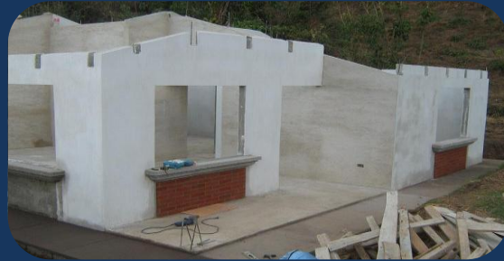
Fig. 52: Ensabietado, repello, cernido, construcción de sillares, fachaleta, hecha de banqueta. Actividades correspondientes al renglón de ACABADOS.
