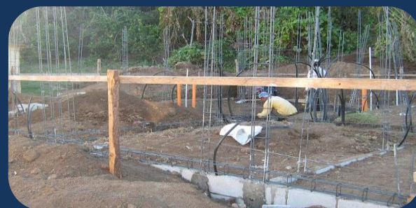
Fig. 47: Levantado dos hiladas, fundición de troncos, armado y fundición solera de humedad.
