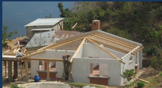
Fig. 54: RENGLON DE CUBIERTA. Lijado de vigas, corte de vigas, montaje de vigas.
