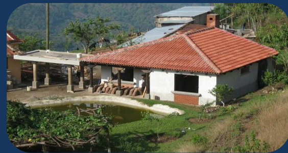
Fig. 56: Repello, blanqueado, hecha de base y capiteles en corredor.
