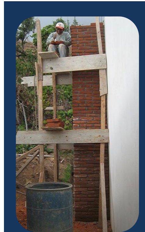
FIG. 61: CONSTRUCCIÓN DUCTO. Mampostería de ladrillo tayuyo de 0.05 * 0.11 *0.23.
