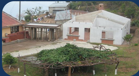
Fig. 53: En esta etapa, la madera se encuentra lista para instalar, se han anexado actividades adicionales del corredor reciente, el piso se encuentra instalado, los muebles fijos ya construidos.
