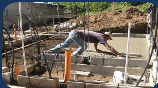
Fig. 49: Fundir contrapiso, por cuestiones de calidad fue importante adelantar esta actividad, tubería de instalaciones ya fue colocada.
