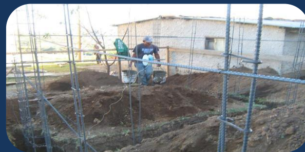
Fig. 46: Fundición del Cimiento Corrido o Caite.
