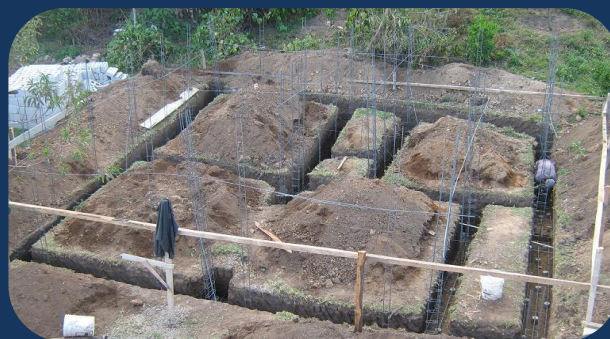
Fig. 45: El zanqueo, La hecha de armaduras, y colocación de armaduras.
