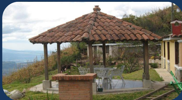
Fig. 42: EL TERRENO. Elementos constructivos existentes.
