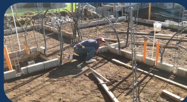
Fig. 48: Colocación de tubería de instalaciones, eléctricas, agua y drenajes, emplantillado primera hilada.
