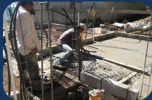
Fig. 59: FUNDICION DE CONTRAPISO. Esta actividad puede ser realizada en la etapa de muros, a final de muros, o bien a final de repellos y cernidos.
