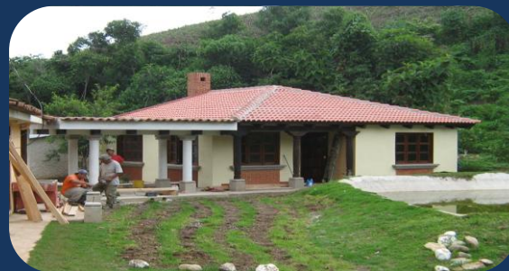
Fig. 57: PROYECTO DE CONSTRUCCION A UN 100%. limpieza, pintura, colocación de lámparas, chequeo de funcionamiento de instalaciones, y entrega del proyecto.
