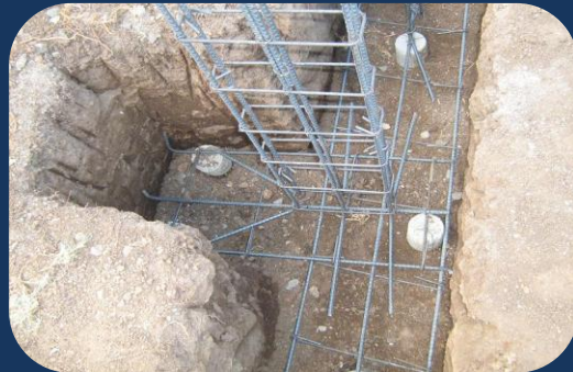
Fig. 58: COLOCACIÓN DE COLUMNA: En este caso las columnas se colocan sobre la armadura del cemento corrido.
