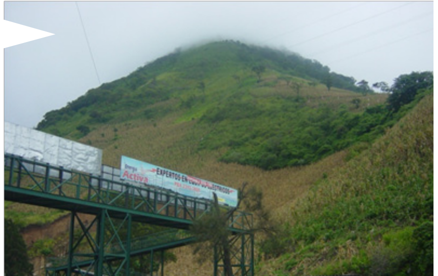
Foto 3.2.7- Foto tomada por Mario Matamoros Aquí se muestra la pasarela y la parada de bus que están próximas al terreno del CECAP. Al fondo se puede observar la vegetación existente del lado del volcán de Agua. Como se puede ver en la gráfica, existe mucho cultivo de maíz.
