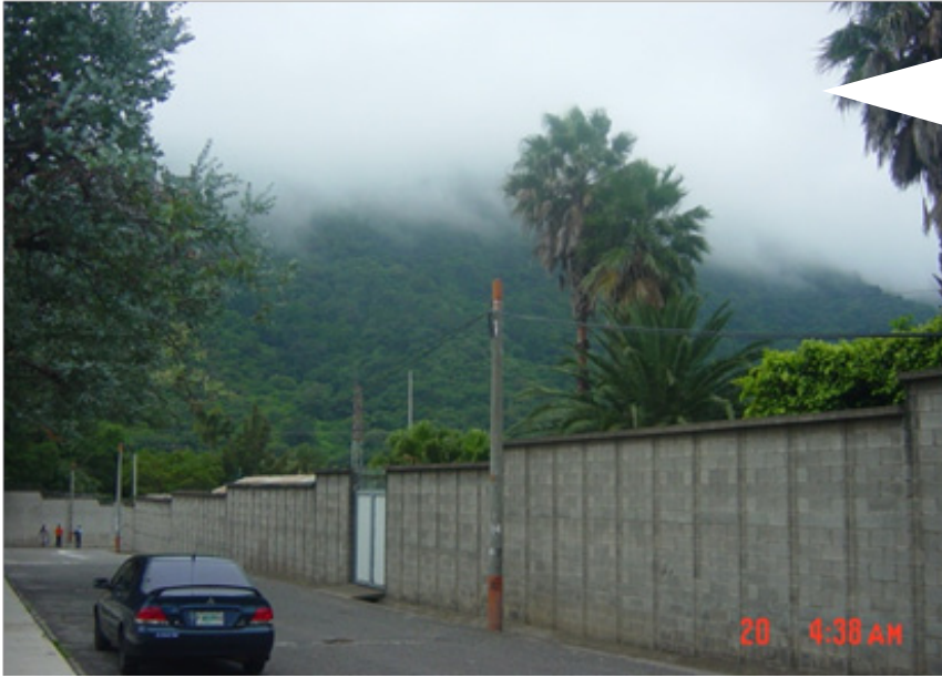
Foto 3.2.10- Foto tomada por Mario Matamoros La empresa Multiperfiles se encuentra protegida por un muro de mampostería, por lo cual esa calle carece de arquitectura visible. Al fondo se puede observar un bosque subtropical, el cual está muy cercano al río Michatoya.
