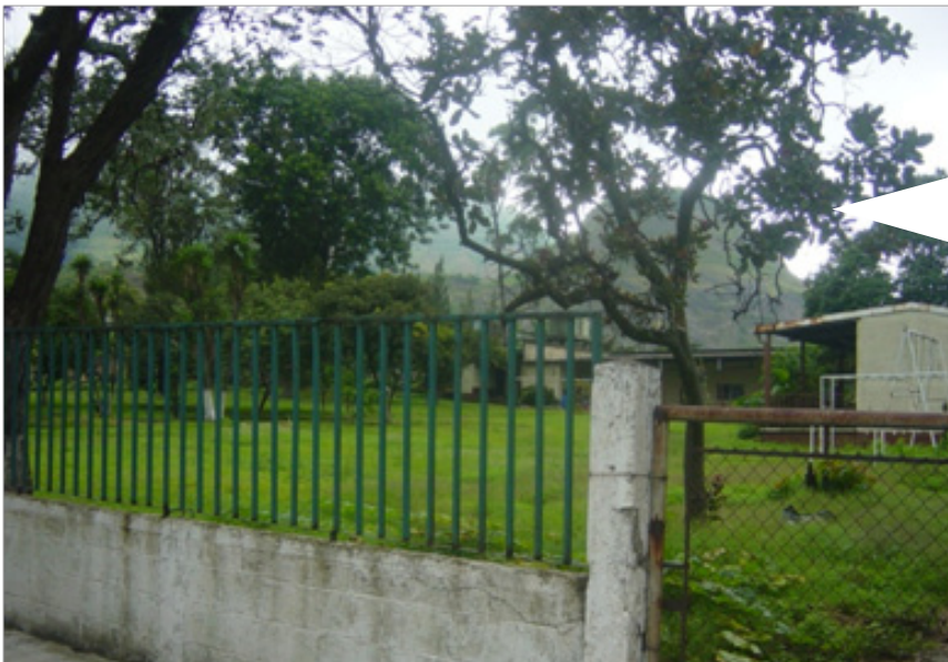
Foto 3.2.5- Foto tomada por Mario Matamoros Aquí se puede observar que el CECAP también contaba con un ingreso de servicio. Al fondo se observa las instalaciones sin uso. Estas instalaciones tienen muros levantados de mampostería, y estructura metálica en el techo.
