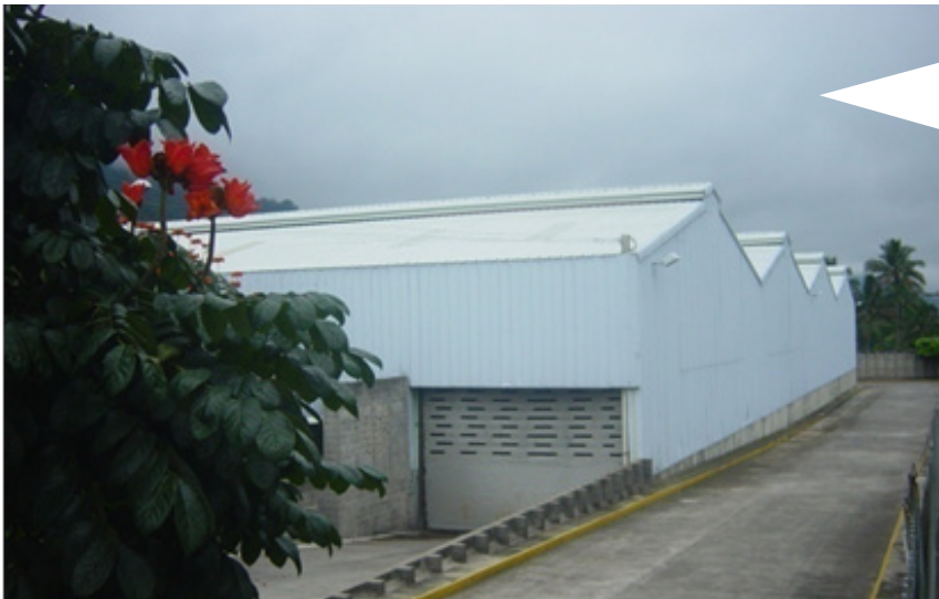
Foto 3.2.11- Foto tomada por Mario Matamoros A la izquierda se puede observar las instalaciones de la empresa Perfiles Metálicos. La envolvente de este edificio es de lámina en su amplia mayoría.
