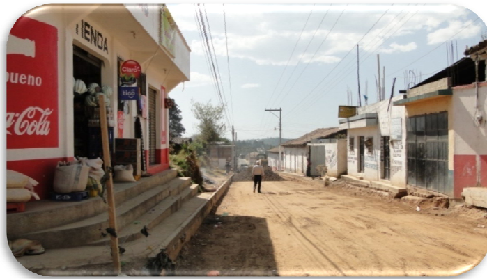
Fotografía 2.6 F26. Calle principal del municipio de San Pedro Jocopilas en reconstrucción. Noviembre 2009
