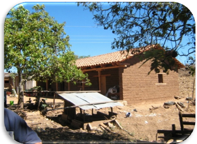
Fotografía 2.6 F34. Viviendas de Adobe en el municipio de San Pedro Jocopilas, Quiche.
