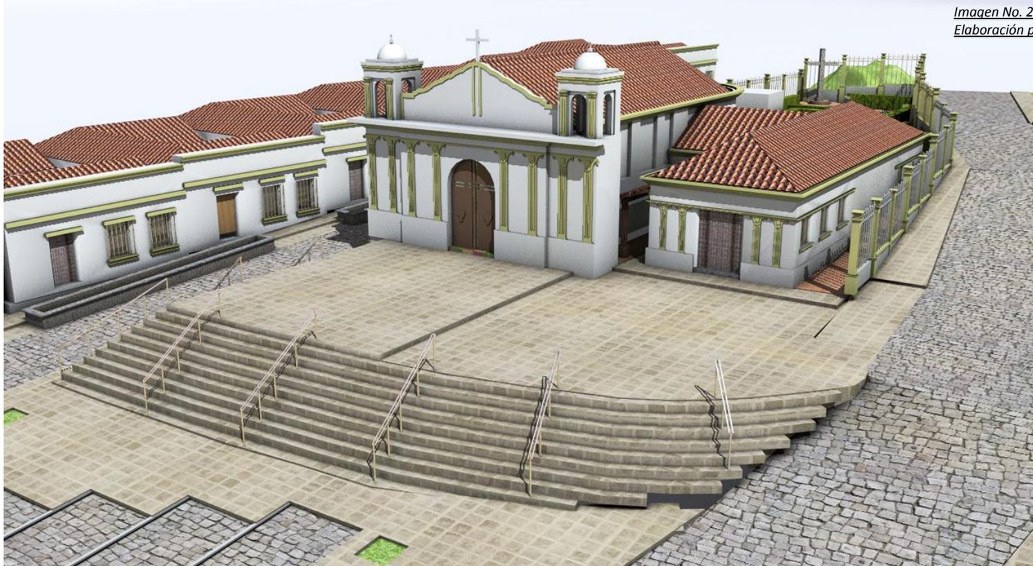
1. La sustitución de la losa plana de concreto reforzado, tanto en el templo como en la sacristía, por cubierta a 2 aguas, que consiste en un artesonado de madera con cubierta final de teja. Esto busca una mejor compatibilidad en el sistema constructivo.
