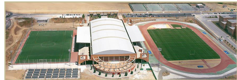
FOTO No. 3: Complejo Deportivo de la Universidad de Málaga
