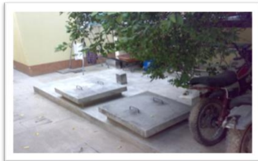
Fotografía No.31 Describe los servicios con los que cuenta el solar Fuente Propia
