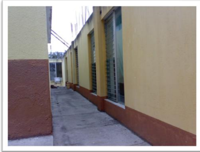
Fotografía No. 36 Describe la estructura de las instalaciones que se encuentran en el solar Fuente Propia
