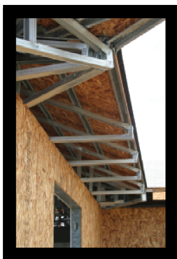
FOTOGRAFÍA No.27 STEEL FRAME + OSB EN MUROS Y TECHO Fuente: www.formacon.cl
