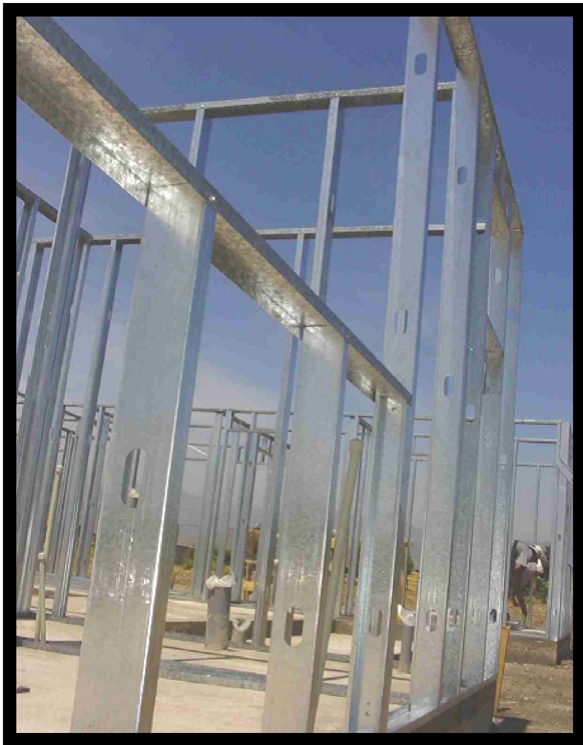
FOTOGRAFÍA No.21 STEEL FRAME
