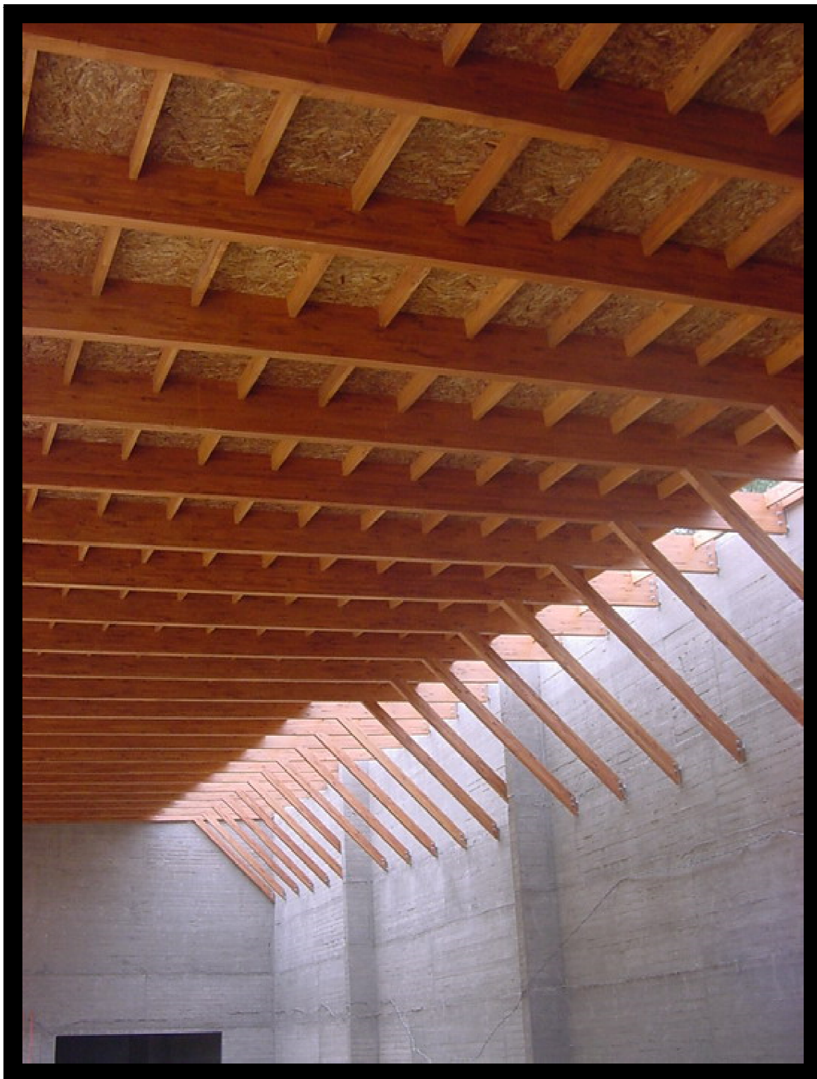
FOTOGRAFÍA No.10 OSB EN CUBIERTA Fuente: www.Plataformaarquitectura.cl
