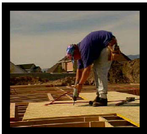
FOTOGRAFÍA No.42 OSB EN ENTREPISOS
