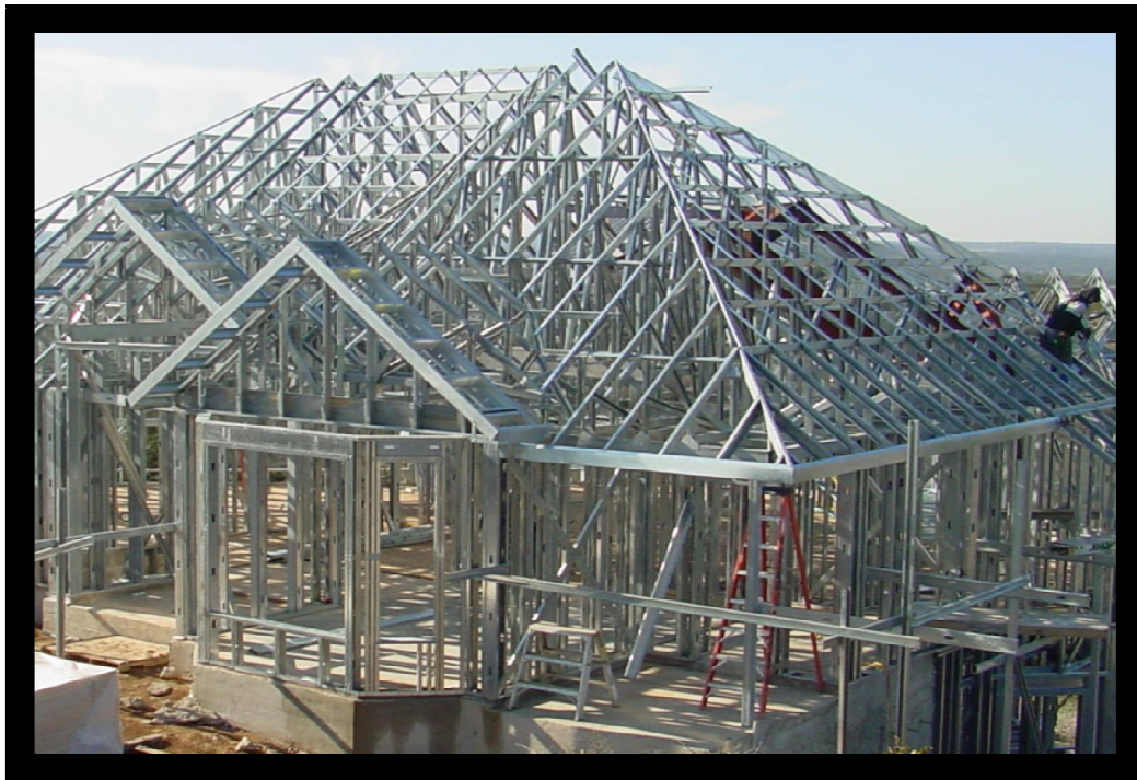
FOTOGRAFÍA No.04 STEEL FRAME
