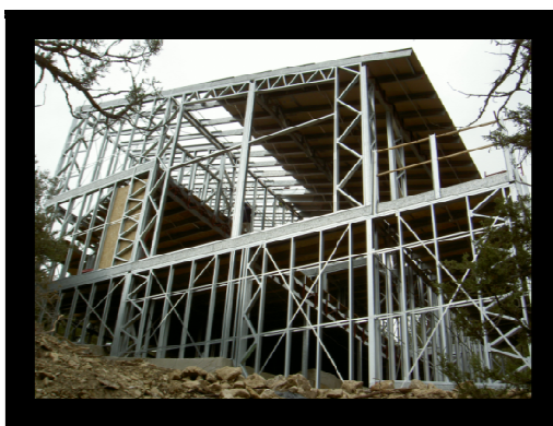
FOTOGRAFÍA No.05 STEEL FRAME
