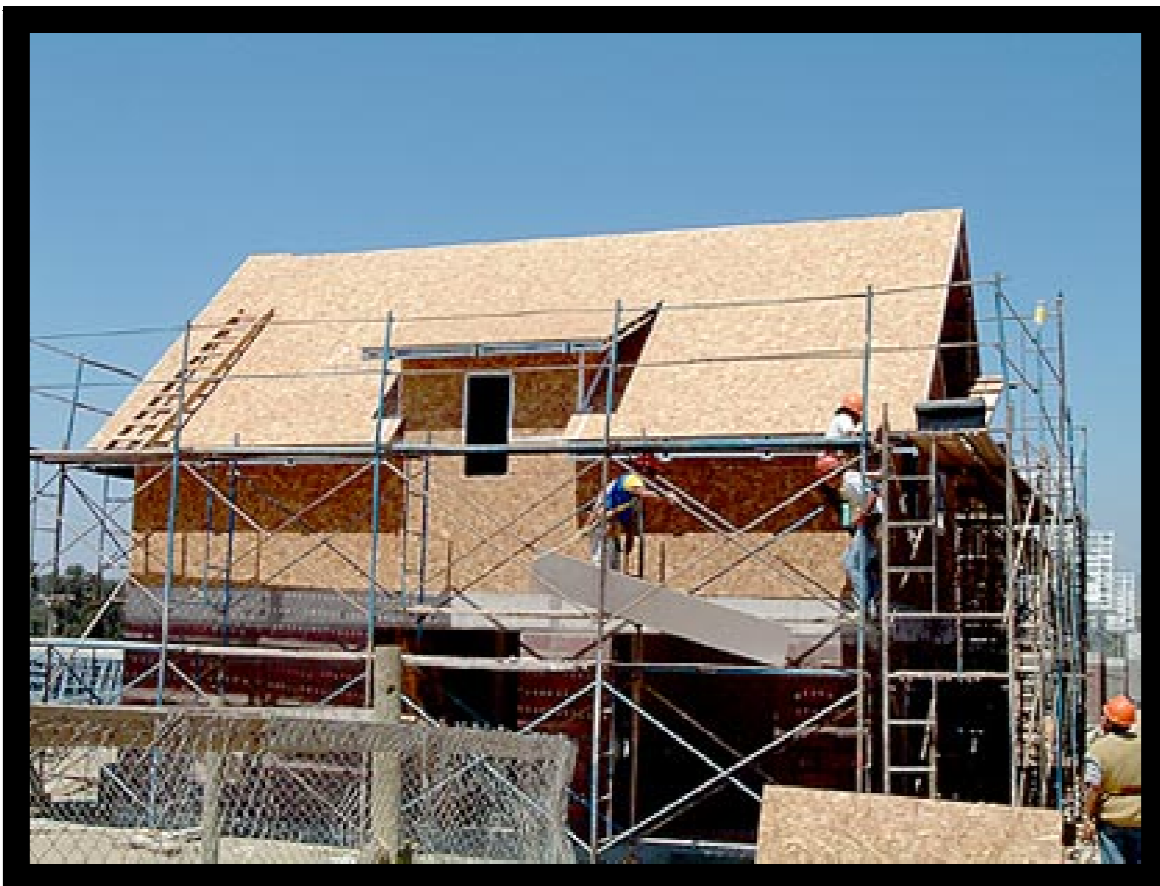
FOTOGRAFÍA No.28 OSB EN CUBIERTA Fuente: http://lpchile.cl
