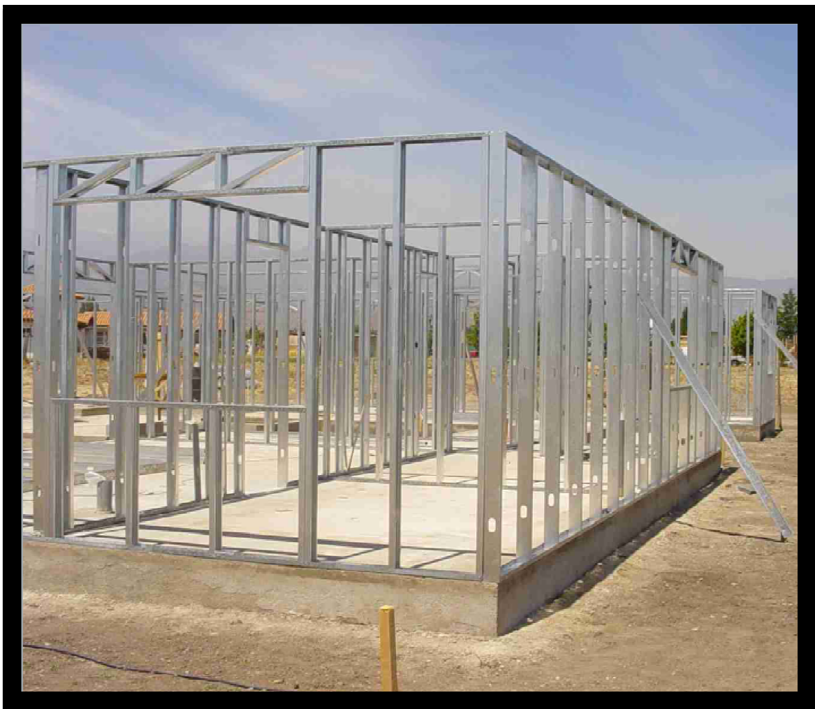
FOTOGRAFÍA No.18 STEEL FRAME
