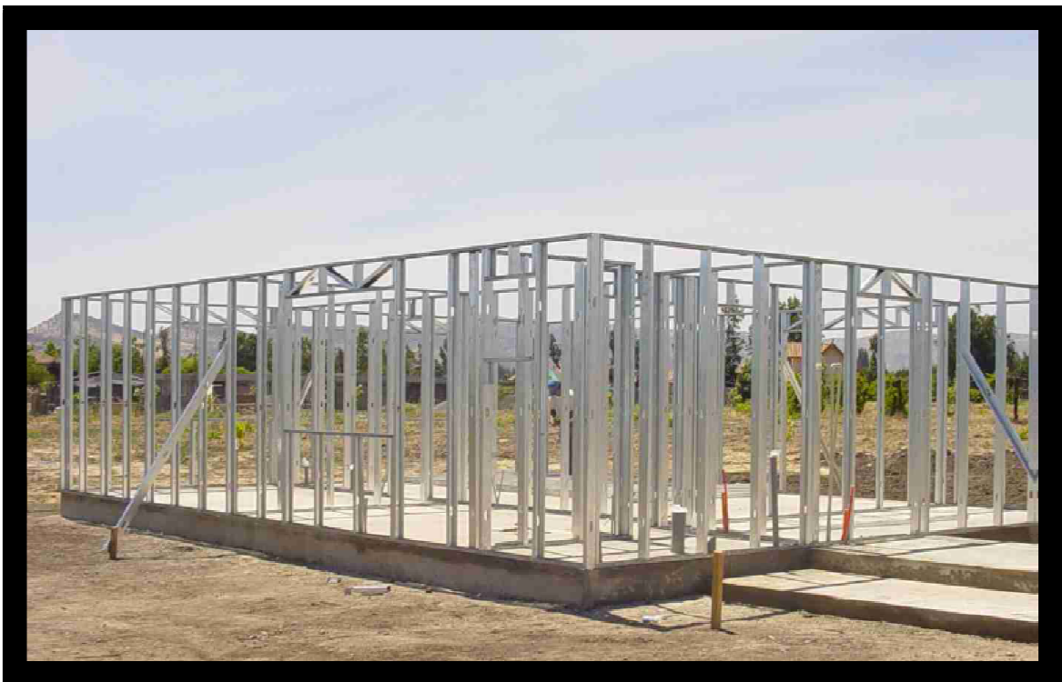
FOTOGRAFÍA No.20 STEEL FRAME
