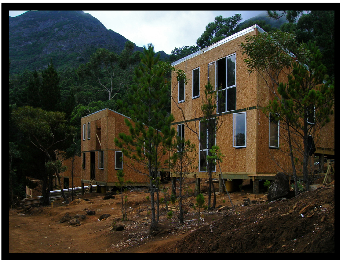
FOTOGRAFÍA No.29 VIVIENDAS DE OSB LISTAS PARA ACABADOS Fuente: http://www.plataformaarquitectura.cl
