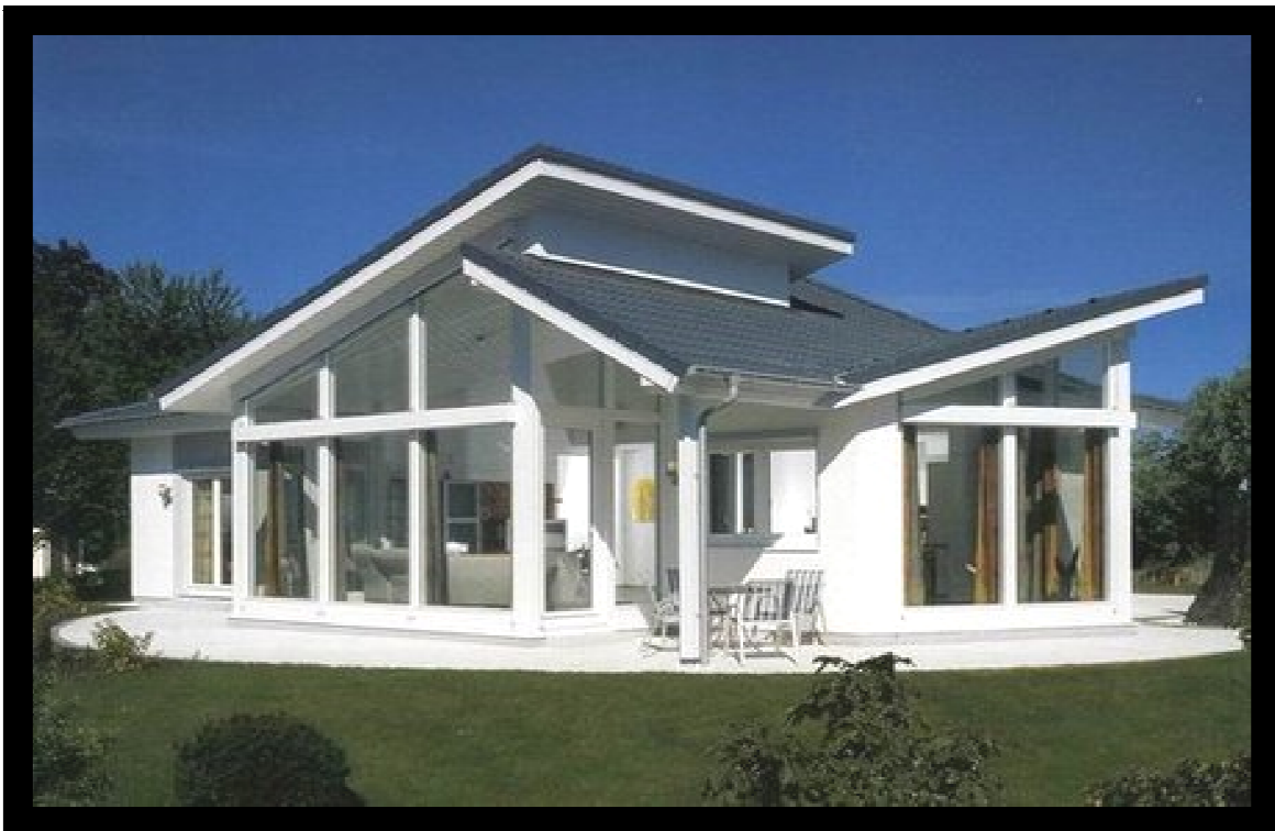
FOTOGRAFÍA No.40 VIVIENDA CON SISTEMA CONSTRUCTIVO EN SECO Fuente: http://www.construccionenseco.com.ar
