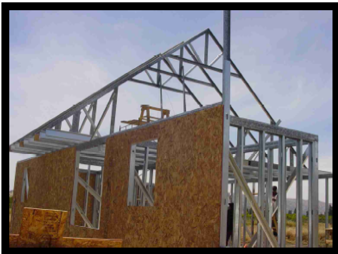
FOTOGRAFÍA No.26 STEEL FRAME + OSB EN MUROS Fuente: www.formac.cl
