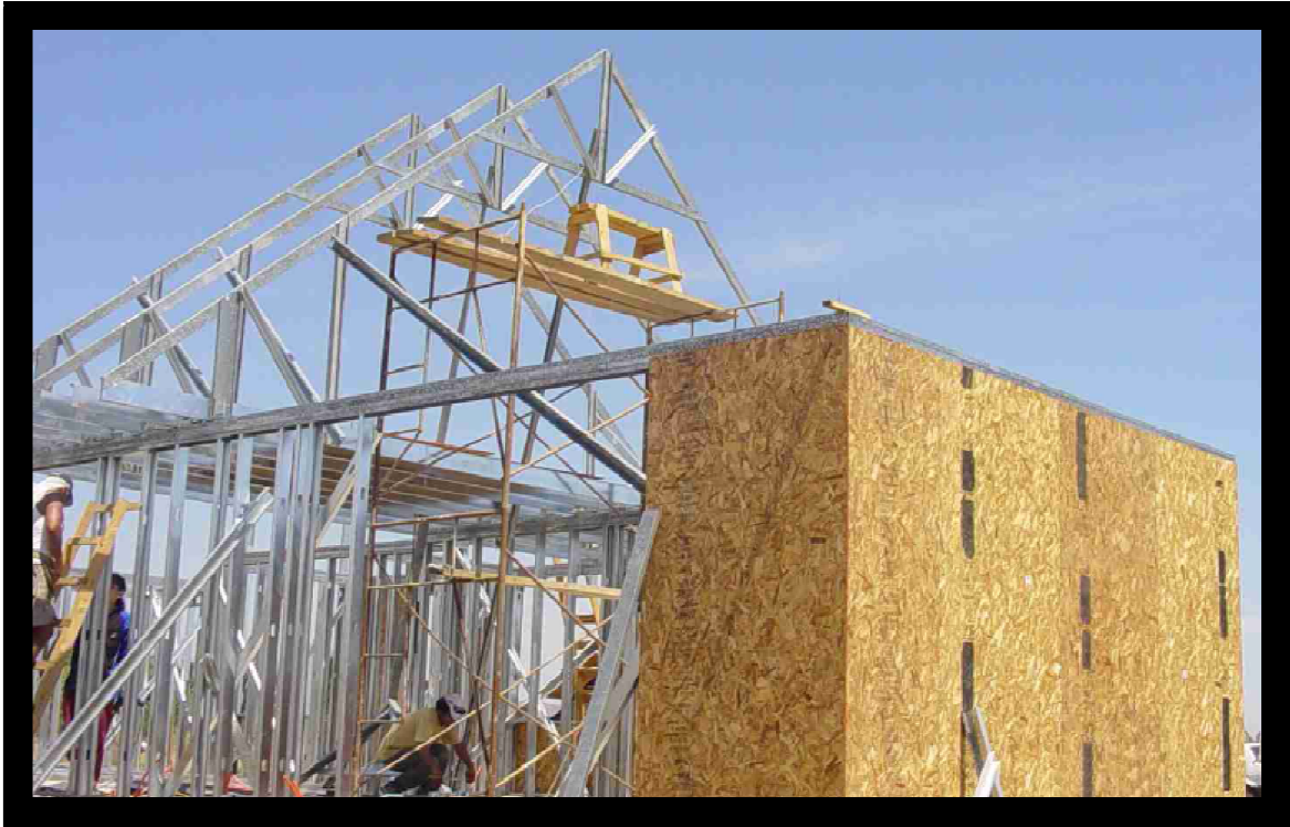
FOTOGRAFÍA No.19 STEEL FRAME + OSB
