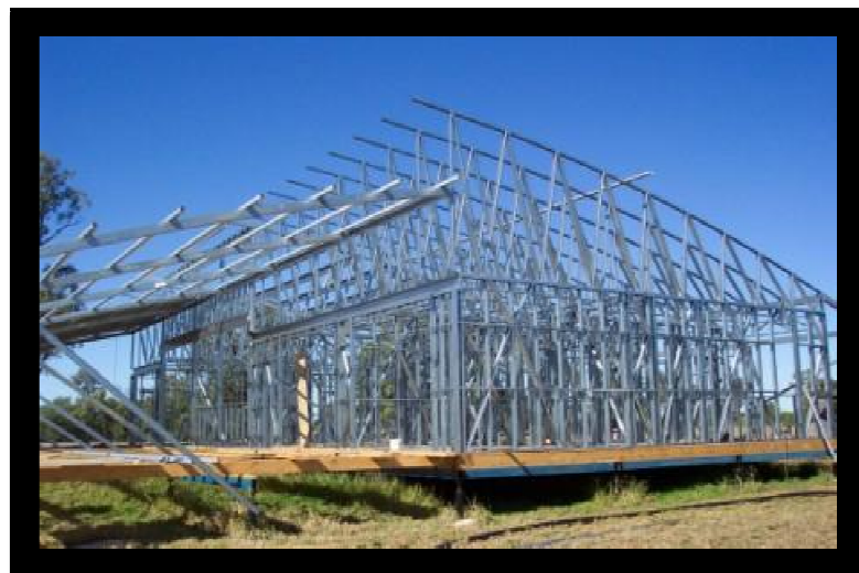
FOTOGRAFÍA No.03 STEEL FRAME
