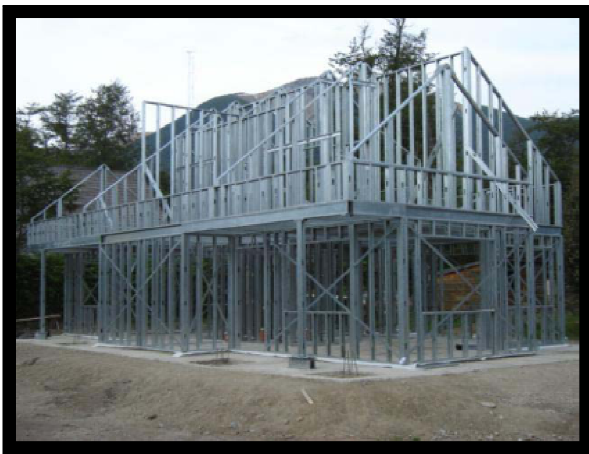
FOTOGRAFÍA No.02 STEEL FRAME Fuente: www.formac.cl
