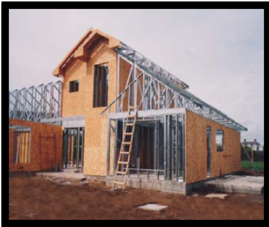
FOTOGRAFÍA No.41 STEEL FRAME + OSB Fuente: http://lpchile.cl
