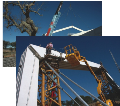
GRÁFICA No 4 PROCESO DE CONSTRUCCIÓN DEL ACUARIO
