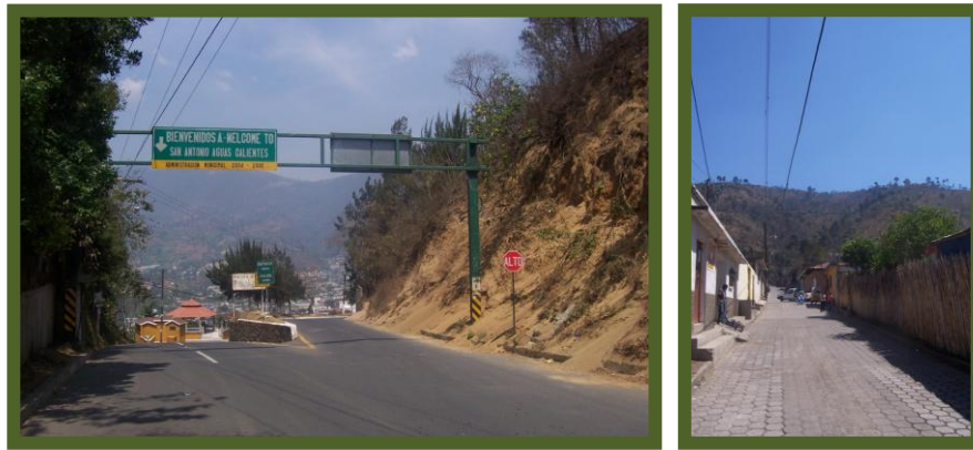
FOTOGRAFÍA 18. VISTA DE LA CARRETERA DE ACCESO PRINCIPAL. FOTOGRAFÍA 19. CALLES DEL MUNICIPIO ADOQUINADAS, INVESTIGACIÓN DE CAMPO, ENERO 2010.
