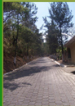
FOTOGRAFIA 7 Calle de acceso al terreno desde el parque central sobre la 1ra. calle de la zona 4, debidamente adoquinada
