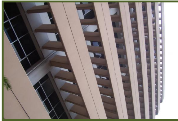
Vista de los parteluces que protegen las ventanas que orientadas hacia el sur
