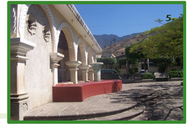
5 VISTA DE LA PILA PÚBLICA EN EL PARQUE CENTRAL DEL MUNICIPIO.
