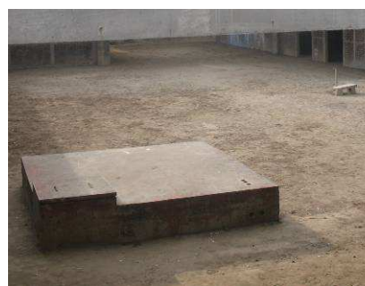
Ilustración 62, Cisternas dentro de Módulos. Por Mario Castillo.
