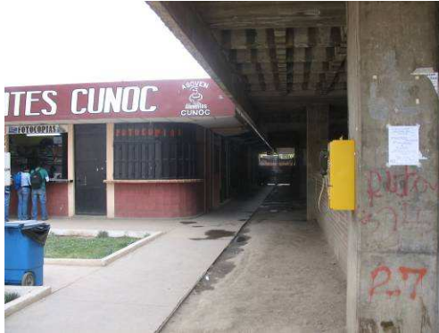
Ilustración 65, Servicios de Telecomunicación Interna del Cunoc. Por Mario Castillo.
