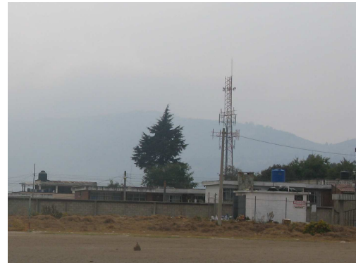
Ilustración 64, Antenas de Comunicación del CUNOC. Por Mario Castillo.
