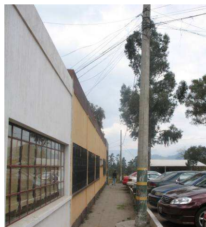
Ilustración 63, Servicio Electrico del CUNOC. Por Mario Castillo.
