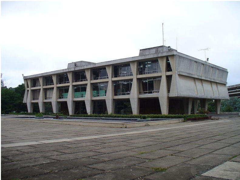
1.1 Edificio de Rectoría de la Universidad de San Carlos de Guatemala.
