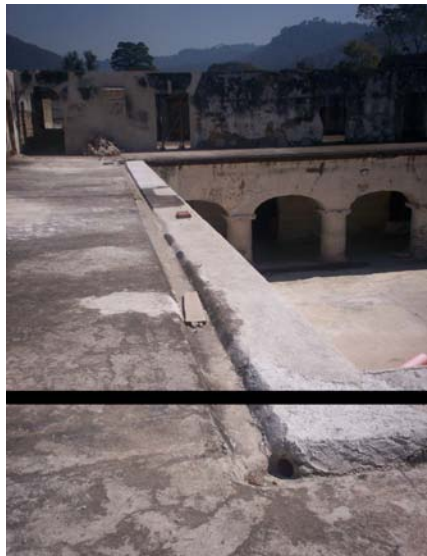
Fotografías 21 y 22: se observa el área del segundo nivel del claustro donde fueron creadas las pendientes y canales para conducción del agua pluvial, así como las bajadas de agua ubicadas dentro de las columnas. Fuente: Elaboración propia, Noviembre 2009.
