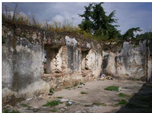
Fotografía 63. Se observa el crecimiento de micro y macro flora en las cabezas de muros.
