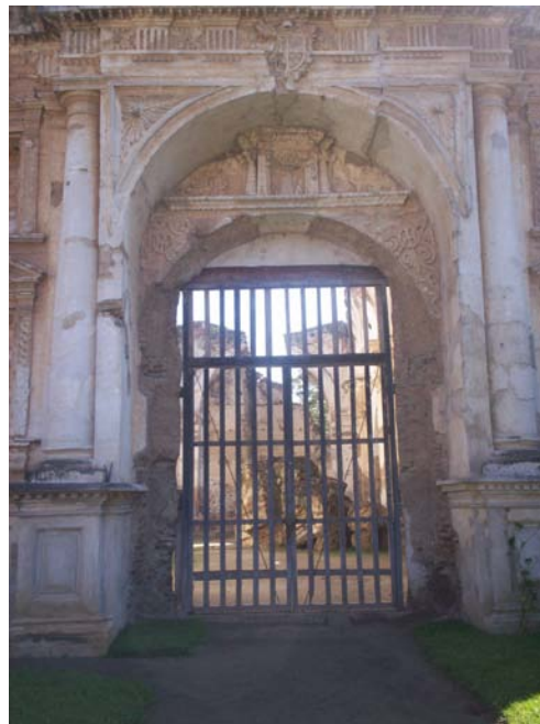
Fotografía 40: puerta de ingreso al Templo, cuyo dintel es de tres puntos, y jambas rectangulares. Fuente: elaboración propia. Noviembre 2009.
