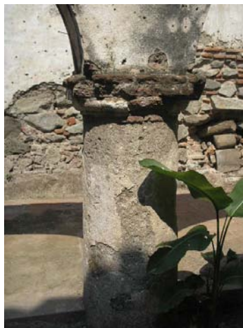
Fotografía 44: Se observa que las columnas están elaboradas con ladrillo de barro cocido. Fuente: elaboración propia. Agosto 2007
