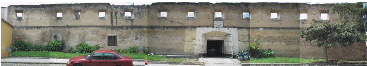
Fotografía 30: se observa la imagen panorámica de la fachada del Convento ubicada sobre la 1ª. Calle Poniente, entre 3ª. Y 4ª. Avenida Norte, La Antigua Guatemala. Fuente: elaboración propia, septiembre 2007.
