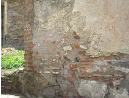
Fotografía 43: Detalle de conformación de muros, de calicanto con rafas de ladrillo de barro cocido. Fuente: elaboración propia. Agosto 2007
