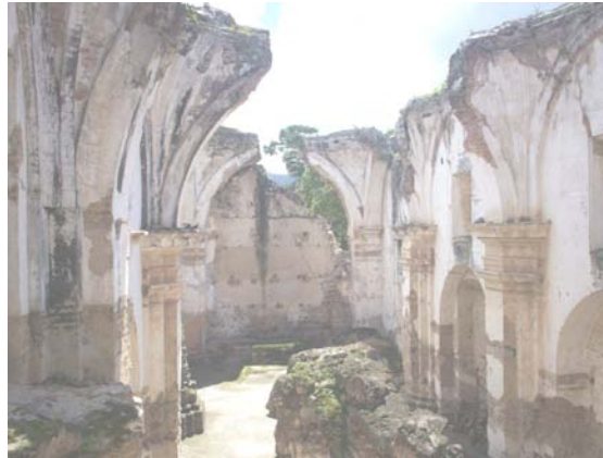
Fotografía 53: vista general del área del templo, donde se observa que en el área del piso se encuentra parte de la cúpula y de las bóvedas. Fuente: elaboración propia, septiembre de 2007.
