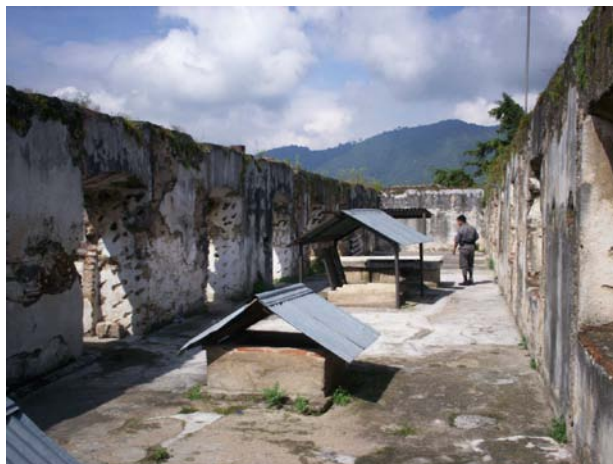
Fotografía 59: vista del segundo nivel del convento donde se observa la integración de módulos de vigilancia, así como la demolición de segmentos de las bóvedas para crear accesos al segundo nivel. Fuente: elaboración propia, septiembre de 2007.
