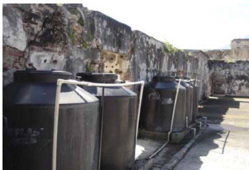
Fotografía 71. Tanques rotoplast en el segundo nivel. Fuente: Archivo Consejo Nacional para la Protección de La Antigua Guatemala –CNPAG-
