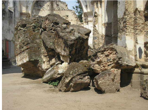
Fotografía 69 y 70. En la primera fotografía se observa el muro testero ubicado al oriente del templo el cual muestra alto grado de deterioro, en la segunda fotografía se puede apreciar que existen vestigios de los arcos que sostuvieron las bóvedas que conformaron la cubierta del templo.
