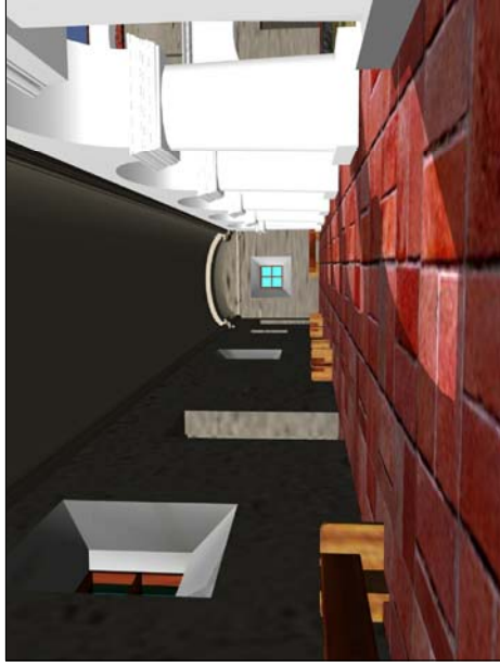
FOTOGRAFÍA No. 7: VISTA DEL CORREDOR UBICADO EN EL ÁREA PONIENTE
