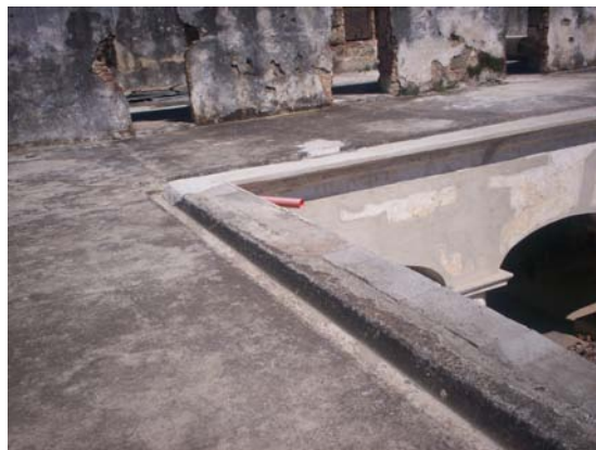
Fotografía 82. En el área del segundo nivel se elevó el nivel de piso a fin de generar un sistema de desfogue de agua cuando se utilizaba el área para el secado de café.
