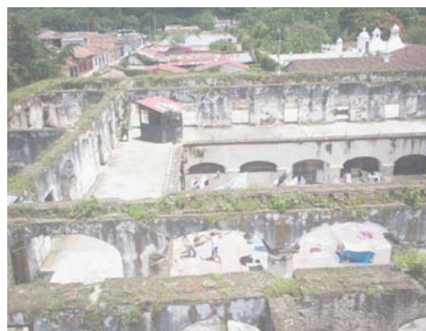
Fotografía 38 y 39: vista del interior del convento, observando el crecimiento de micro y macro flora, así como la falta de cubierta. Fuente: elaboración propia, septiembre 2007.
