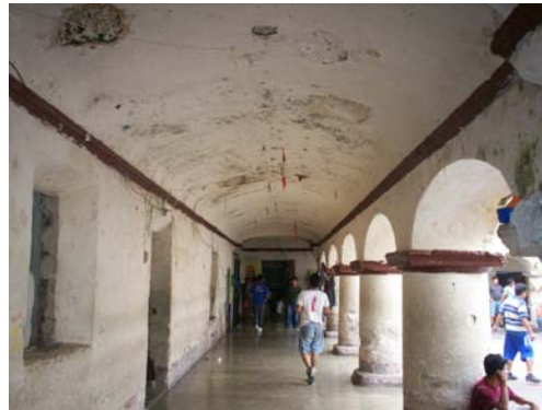
Fotografía 74. Aplicación de pintura de aceite en los muros, columnas y bóvedas área del convento.
