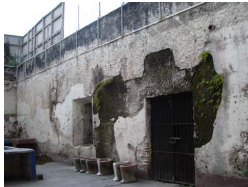
Fotografía 75 y 76. Se observa en las fotografías el área del convento, donde existen ventanas de perfiles de metal, y vidrio; y en el caso de las puertas se observa que todas corresponden a puertas de rejas de metal.
