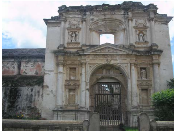
Fotografía 29: vista de la fachada frontal del Templo, observando sus dimensiones, proporciones y elementos decorativos. Fuente: elaboración propia, septiembre 2007.
