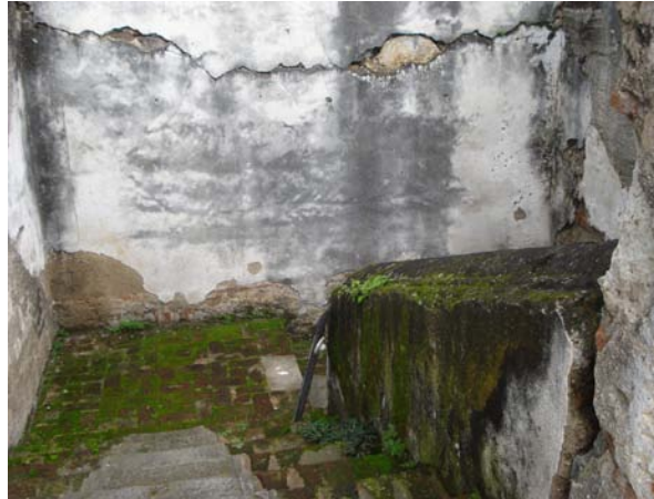
Fotografía 56: se observa el modulo de gradas ubicado en el área poniente del edificio. Fuente: elaboración propia, septiembre de 2007.
