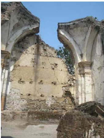
Fotografía 69 y 70. En la primera fotografía se observa el muro testero ubicado al oriente del templo el cual muestra alto grado de deterioro, en la segunda fotografía se puede apreciar que existen vestigios de los arcos que sostuvieron las bóvedas que conformaron la cubierta del templo.
