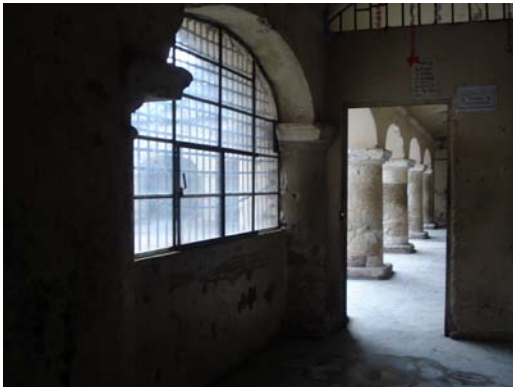
Fotografía 75 y 76. Se observa en las fotografías el área del convento, donde existen ventanas de perfiles de metal, y vidrio; y en el caso de las puertas se observa que todas corresponden a puertas de rejas de metal.
