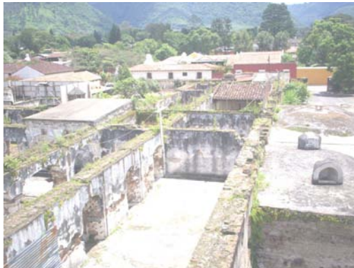
Fotografía 54 y 55: vista general del área del convento, donde se observa que en el área del segundo nivel carece de la cubierta, que de acuerdo a los vestigios fue artesonado de madera y teja. Fuente: elaboración propia, septiembre de 2007.
