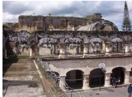
Fotografía 54 y 55: vista general del área del convento, donde se observa que en el área del segundo nivel carece de la cubierta, que de acuerdo a los vestigios fue artesonado de madera y teja. Fuente: elaboración propia, septiembre de 2007.
