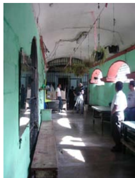
Fotografías 51 y 52: se observa la bóveda que constituye la cubierta en el área del corredor dentro del Convento. Se puede apreciar también la cubierta de entrepiso en el área de la Sacristía. Fuente: elaboración propia, septiembre de 2007.
