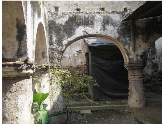
Fotografía 45: Detalle del arco elaborado con ladrillo de barro cocido, ubicado en el área del corredor frente a la Sacristía. Fuente: elaboración propia. Agosto 2007
