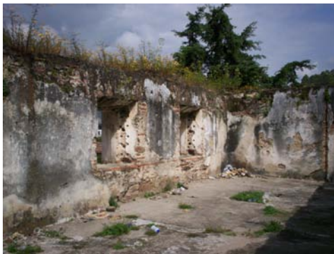
Fotografía 38 y 39: vista del interior del convento, observando el crecimiento de micro y macro flora, así como la falta de cubierta. Fuente: elaboración propia, septiembre 2007.
