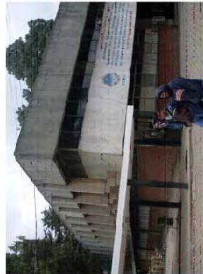
Fotografía No. 12 elaboración propia. Se puede observar que se utilizan parteruces en las fachadas que están expuestas al sol de la tarde.
