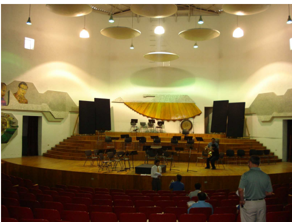
VISTA DEL ESCENARIO DE MADERA CON PANELES ACÚSTICOS SOBRE EL MISMO
