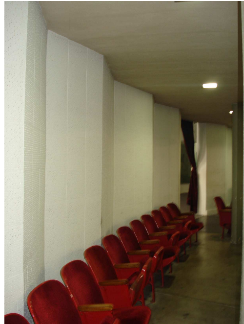
FORRO DE MURO CON PANELES DE CARTÓN CALADO
