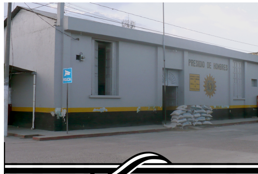
Fotografía No. 15 Presidio de hombres, Jalapa.
