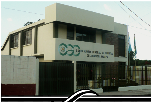
Fotografía No. 17 Contraloría General de Cuentas, Jalapa.
