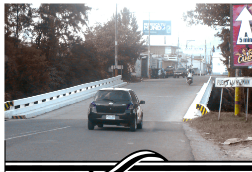
Fotografía No. 6 Puente Las Guzman, ingreso a Jalapa.
