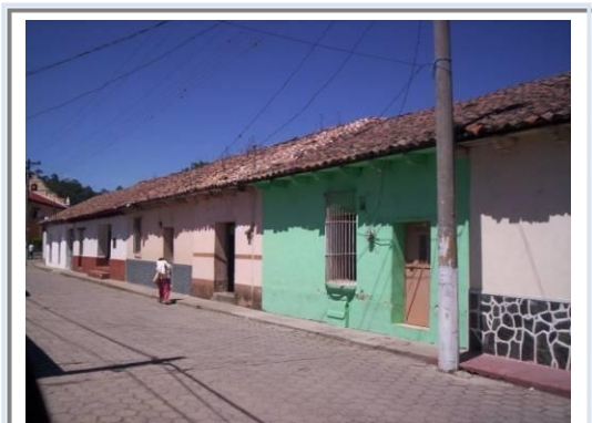
Imagen 29 Vivienda tipo V-1 Fuente: Propia, 2009.
