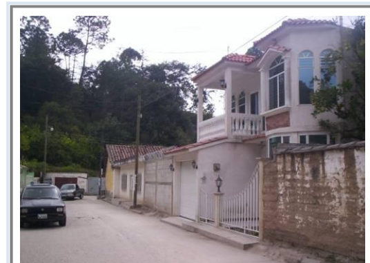
Imagen 30 Vivienda tipo V-2. Fuente: Propia, 2009.
