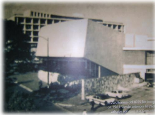
IMAGEN 43. AUDITORIO OFICINAS CENTRALES IGSS
