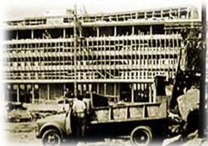
IMAGEN 25. Construcción Edificio Municipalidad Centro Cívico, Guatemala. Fuente: http://.muniguate.com Fotografía Digital.
