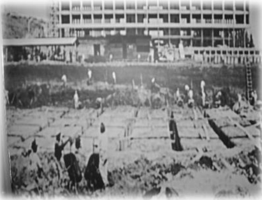
IMAGEN 39. Trabajos cimentación edificio, atrás Edificio Municipalidad de Guatemala.
