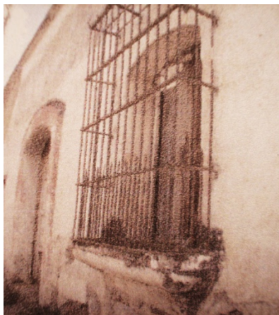
Ventanas de proporciones 1:1.5, balcones con dobleces en la puntas, sillar de pecho de paloma, época colonial. fuente: Pablo González 2006.
