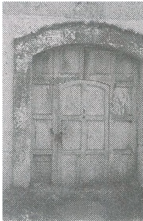
Identificación del zaguán con arco rebajado, época colonial. fuente: Pablo González 2006.
