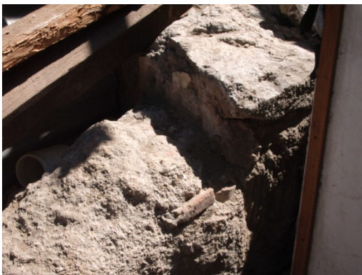
Muros de Adobe. fuente: Pablo González 2009.
