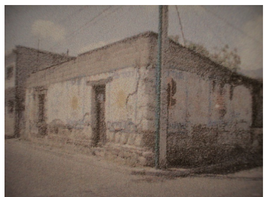
Fachada inmueble en estudio. fuente: Pablo González 2009.
