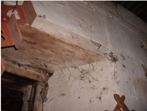
Macizo de Madera en Dinteles de Puertas. (Vivienda en estudio) fuente: Pablo González 2009.
