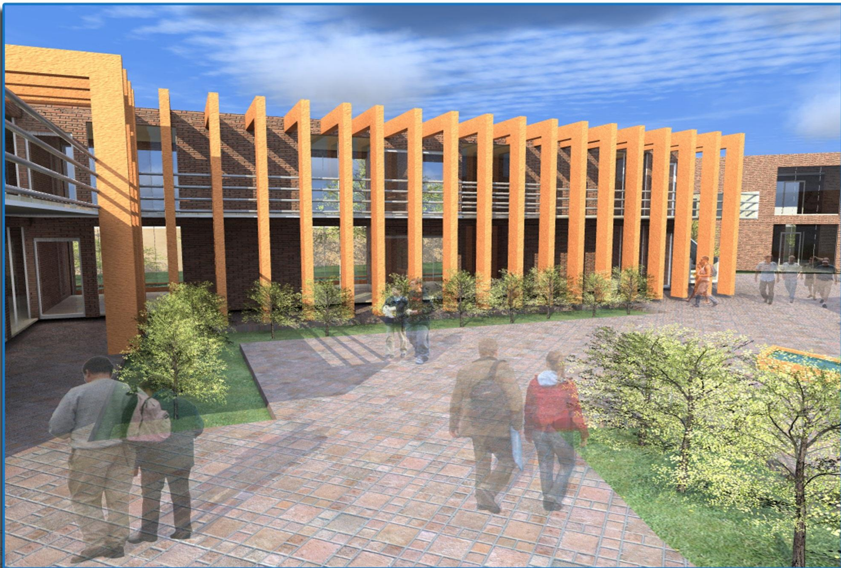
FACHADA PRINCIPAL DE AULAS PURAS
