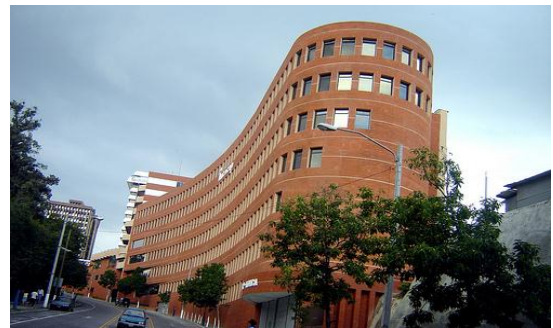
Fachada principal sobre la calle Mateo Flores
