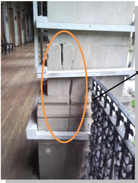
En la fotografía se pueden observar los daños que la estructura del edificio municipal de Quetzaltenango tiene a la fecha como lo son grietas y fisuras en las columnas, las cuales las han reforzado con una sobre estructura de madera a manera de encamisar la columna, dicha medida solo es una solución temporal para que a la columna no se le desprendan pedazos de piedra que es el material con que se construyeron las mismas sin embargo esta no es una solución estructural.
