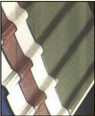
TECHO DE GRADERIO DE PISCINA: LA FORMA DE TECHAR EL GRADRIDO ES DE ESTRUCTURA METALICA Y CUBIERTA DE LAMINA DE PERIL TROQUELADO.
