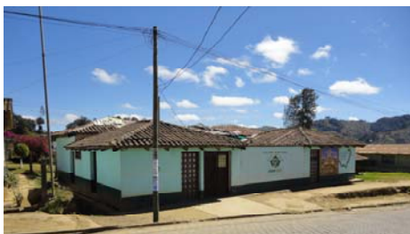
Vivienda ubicada en la zona I
