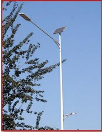
**Imagen 21:** Luminarias LED, con panel solar para la iluminación de calles y avenidas.
