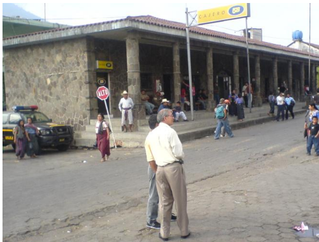
Foto No. 27 del Edificio Municipal de Santiago Atitlán. 2008 Elaborado: Rita Aquino
