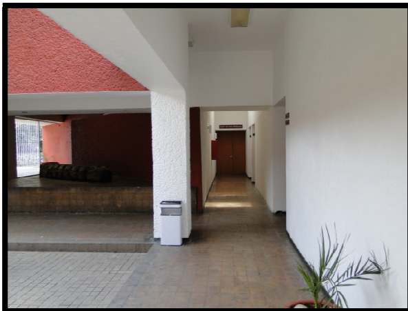
Foto 1 J: Elaboración Propia C Se observa la iluminación por medio de tragaluces en la Quinta Colorada, resolviendo así pasillos sin iluminación en cerramientos verticales.
