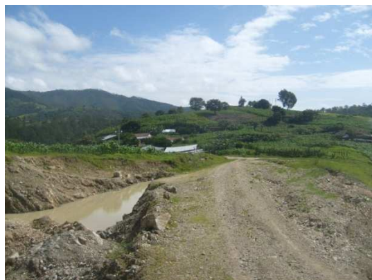
Foto2D: Elaboracion propia Camino adyacente al terreno en la parte sur. Se observa un poco de encharcado en el area donde se saca material.
