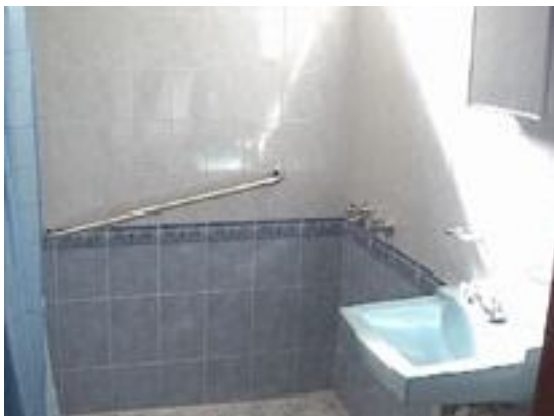
FOTOGRAFÍA 5: duchas (muy pequeñas) AÑO: 2009 FUENTE: Elaboración Propia
