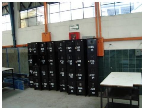
Fotografía 7: Muestra la insuficiencia de un área especificada destinada para lockers.
