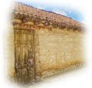
Los muros contemplados en este análisis muestran dos tipos específicos de materiales para su realización; la madera y el adobe, siendo este último el más utilizado debido a su modo de obtención, el cual es fabricado de una manera artesanal.
