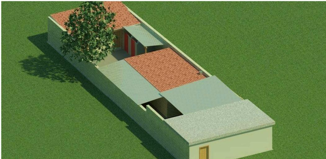
En la siguiente vista aérea se puede observar la disposición de cada una de las inclinaciones de sus cubiertas, así también se observa los diferentes tipos de materiales que las conforman, logrando apreciar los siguientes, en la parte de enfrente o fachada se maneja una cubierta de losa de concreto, en áreas de conexión y pasillos lámina y en áreas de servicio, cocina-comedor y dormitorios estructura de madera, lámina y teja.
