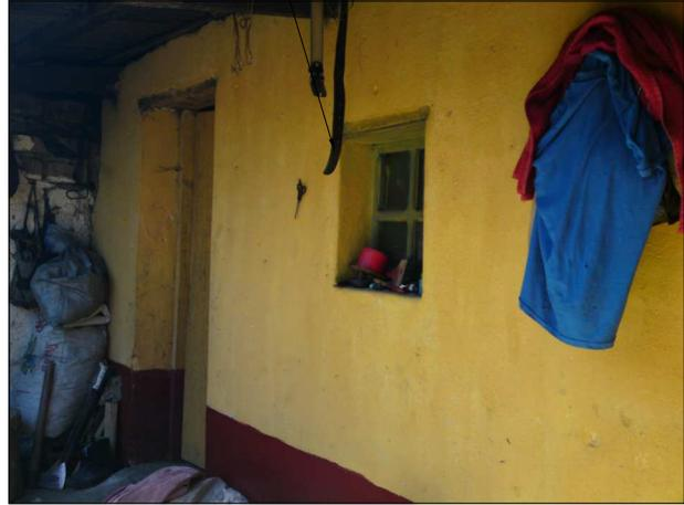
La disposición de ventanas en el muro en esta tipología no pasa de un tercio de ancho total de muro lo que hace guardar mas firmeza cumpliendo asi con los requerimientos de este tipo de sistema constructivo.
