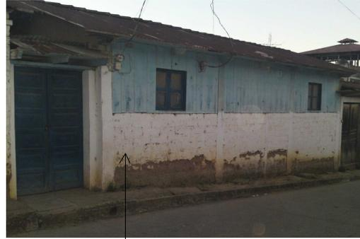
En esta fotografía se puede apreciar la conformación de la fachada de esta vivienda, la cual se compone de un cerramiento vertical mixto, adobe con madera así también se denota la utilización de piezas de madera para la conformación de la estructura de cubierta y lámina para el cubrimiento total de la misma.
