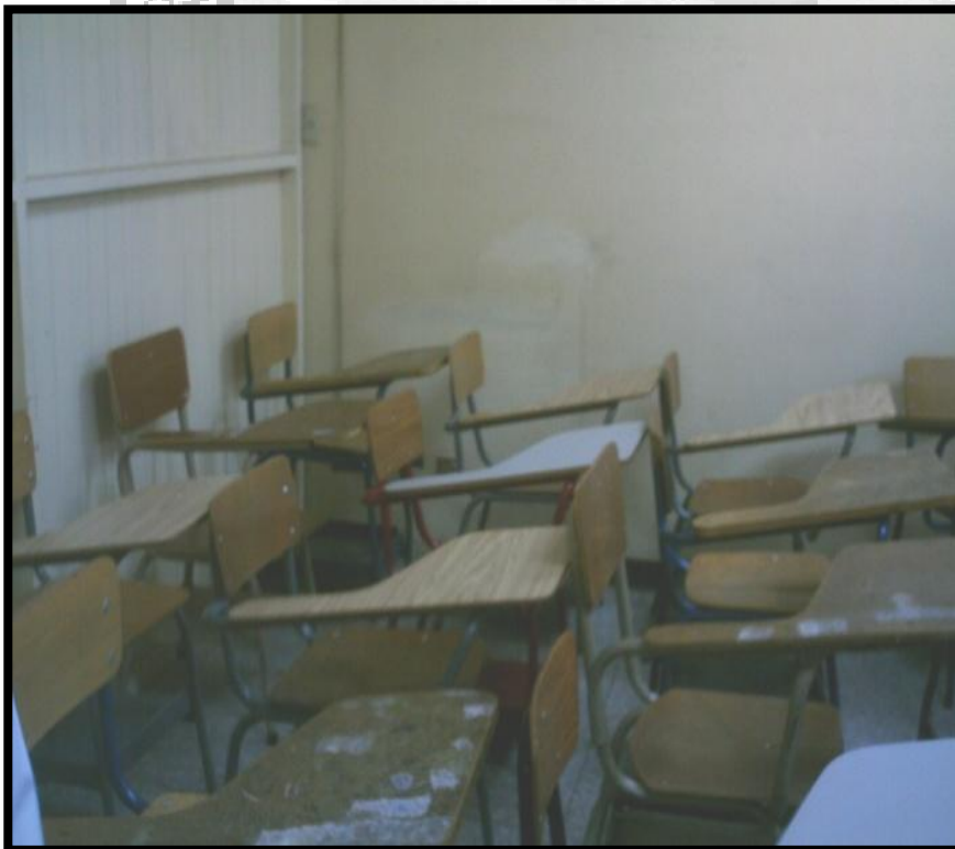
Fotografía 14: "Aula 1" Fuente Propia
