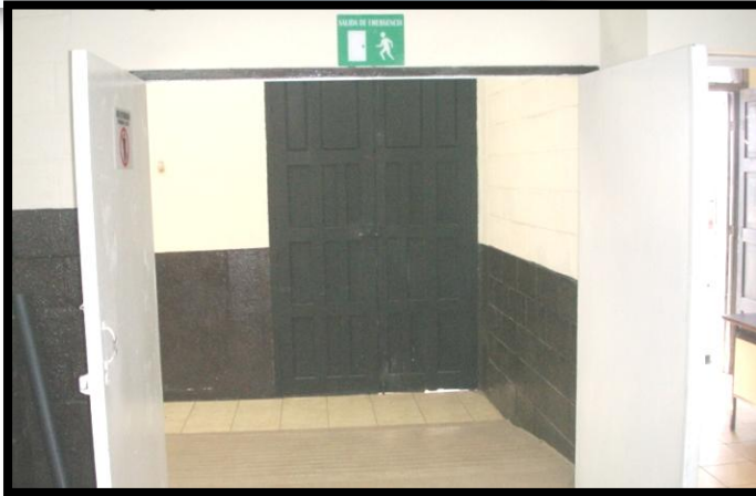
Fotografía 31: "Ingreso Morgue" Fuente Propia.
