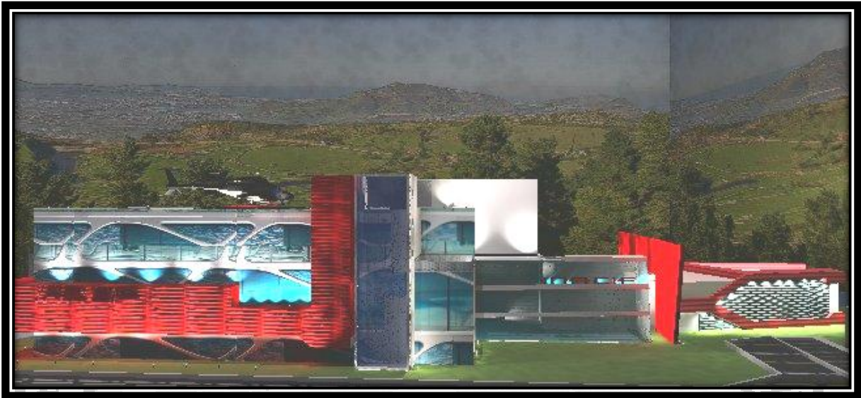
Ilustración 71: Elaboración Propia----Fachada Frontal del INACIF
