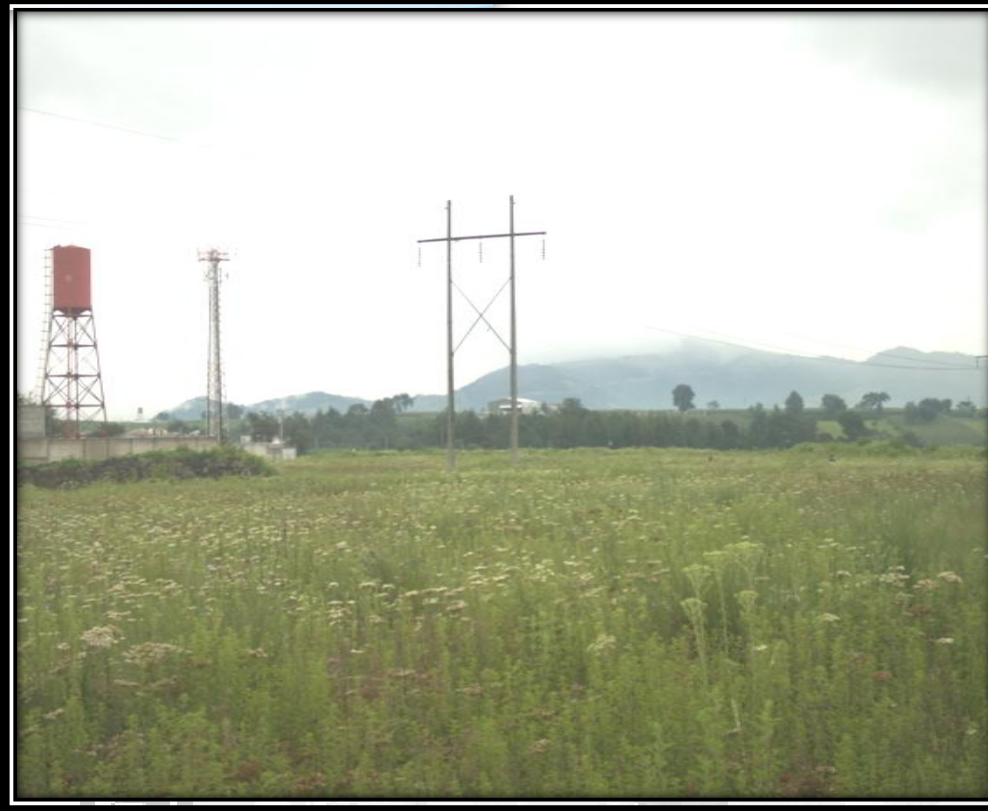
Fotografía 5 Fuente: Propia.--PARTE POSTERIOR DE CONDOMINIO MARGARITAS
