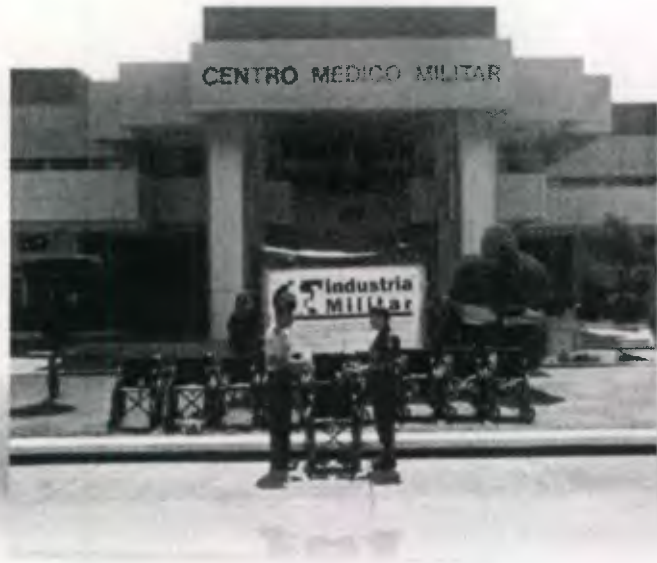
FOTO No. 12 Toma del acceso al Hospital Militar, Guatemala.
