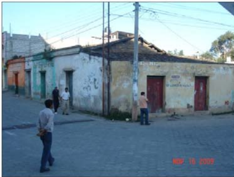
No. 4: Esquina de la 2da Avenida y 5ta calle en la cual se aprecia una de las viviendas consideradas patrimonio cultural.
