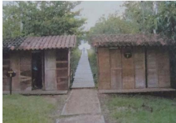
**1.9.2.3 Fotografía 5:** El área de vestidores, son de aspecto formal simple, con cerramientos verticales de madera y una cubierta de teja. Dos módulos uno para damas y otro para caballeros divididos por un sendero que se dirige a la laguna. Cada uno está conformado por 2 cabinas, ambos elevados del suelo por pilares sobre una tarima de madera, con un área de 6.50m por módulo.
