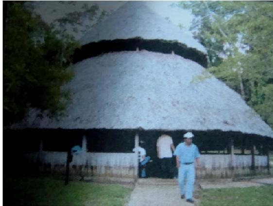
**1.9.2.3 Fotografía 6:** El salón educativo, es un área semi abierta, con un muro de 0.90 m en su perímetro, hecho de varas de bambú, sostenido por columnas de maderas con una separación de 2 metros y medio, con un techo segmentado que permite la circulación del viento en la parte superior creando un ambiente confortable en el interior. Por sus dimensiones majestuosas, motiva a las personas que se acerquen a él.
