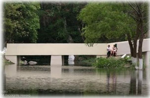
Foto 6: Presa en Matanzas
