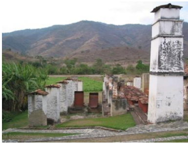
Fotografía No. 35 Calderas
