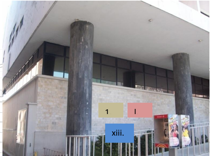
Losa de Concreto, Fachaleta
