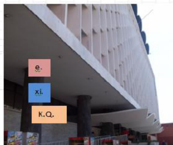
Columnas Fachaleta de Mármol Negro
