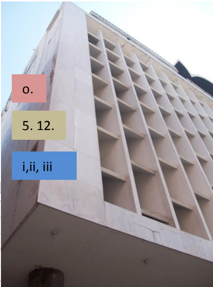
Muro con Fachaleta de Mármol Blanco
