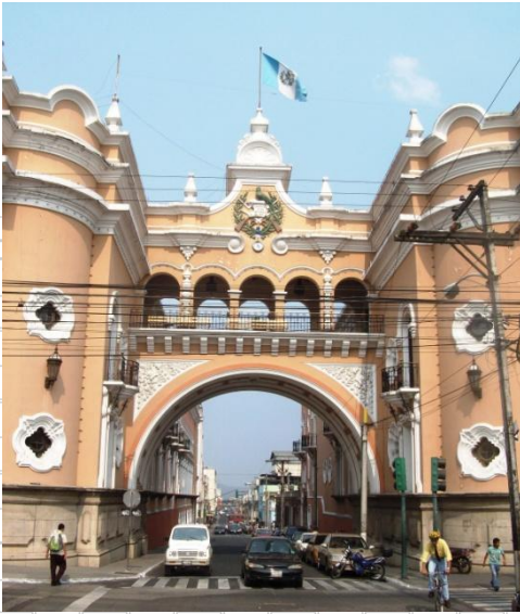
Imagen No. 5 [Antiguo Edificio de Correos y Telégrafos] Autor: E. Suárez Reynoso Fecha: 28/04/11
