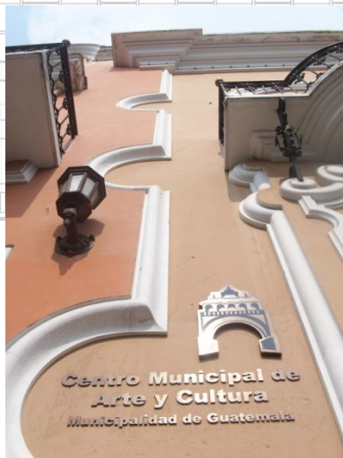
Imagen No. 23 [Antiguo Edificio de Correos y Telégrafos] Autor: E. Suárez Reynoso Fecha: 28/04/11
