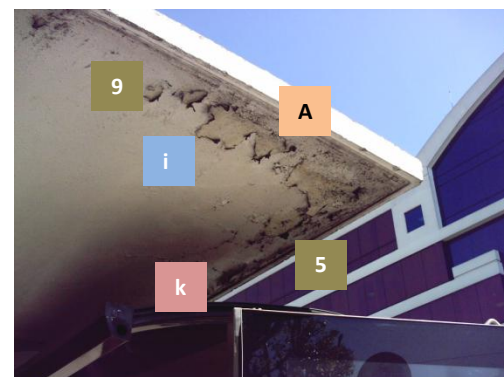
Fotografía No. 24 Voladizo edificio Italia Autor/Fotografía: Luis Cortez
