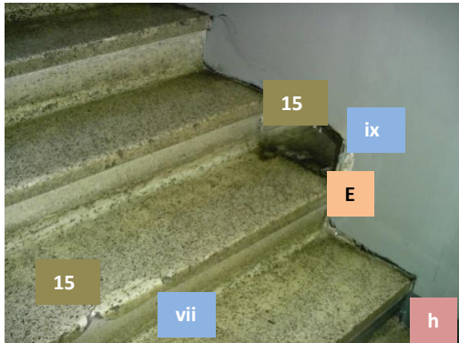
Fotografía No. 32 Escalones nivel 1 a 2 Autor/Fotografía: Luis Cortez
