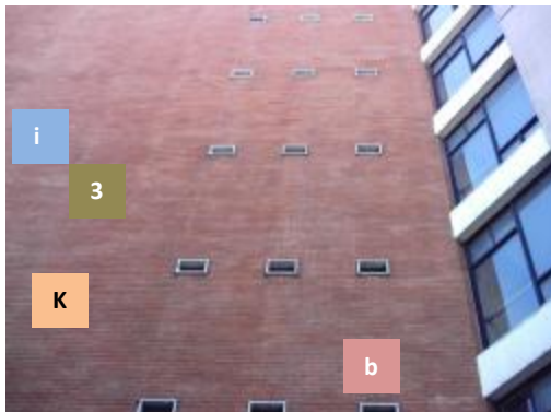
Fotografía No. 21 Muro de ladrillo Autor/Fotografía: Luis Cortez
