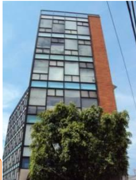
Fotografía No. 15 Placas de asbesto Autor/Fotografía: Luis Cortez
