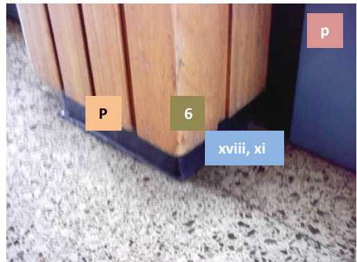
Fotografía No. 33 Forro de madera Autor/Fotografía: Luis Cortez
