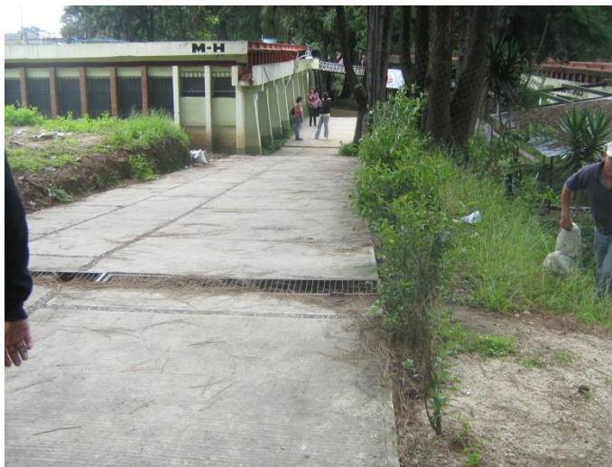
Ingreso Peatonal EFPEM Fotografía No. 46
