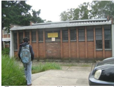
Estructura utilizada para la Construcción de la EFPEM
