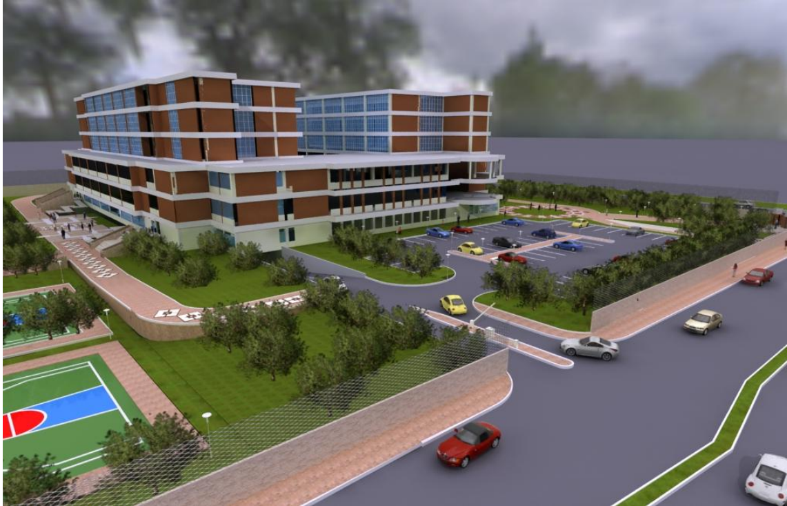
APUNTE INGRESO DESDE A SÓTANOS DESDE AV. PETAPA
