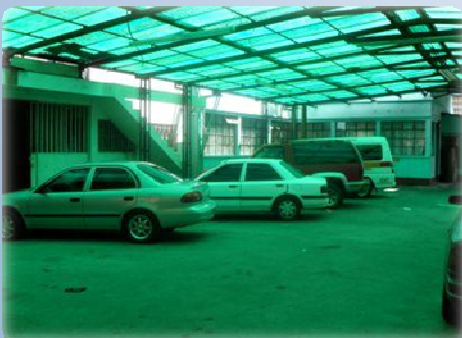
El techo es de lámina plástica lo que hace un ambiente caluroso, con poca ventilación.
