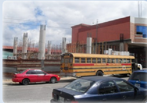
Vista del proceso de construcción del edificio dos de la Estación Central de bomberos
