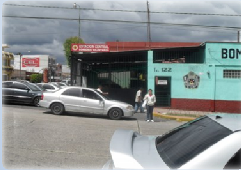
Se observan las instalaciones que por su tiempo ya están un poco deterioradas y no se define el ingreso vehicular y peatonal.
