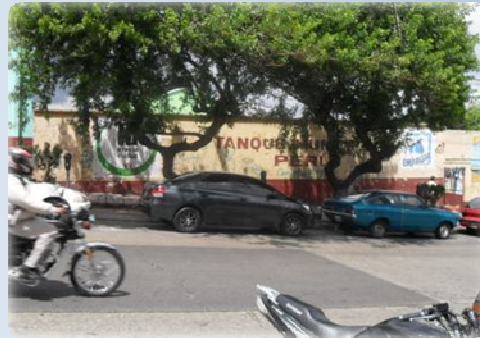
Vista lateral, tanque municipal de agua, parqueos frente al ingreso, ubicado sobre la 19 calle, zona 3.
