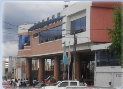
Fachada de la Estación Central de Bomberos Voluntarios sobre la primera avenida zona 3.
