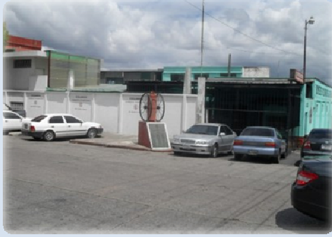
Ingreso vehicular y personal, esquina entre la 19 calle y primera avenida, zona 3, portón de ingreso vehicular y pared de circulación de block con repello.
