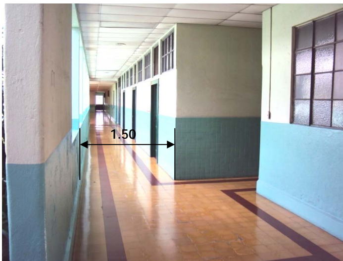
Fotografía 11 Pasillo afuera de las aulas Fuente: Propia
