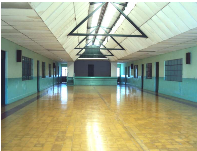
Fotografía 12 Salón Fuente: Propia
