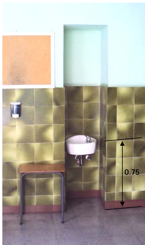
Fotografía 15 Detalle de Lavamanos Fuente: Propia
