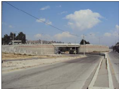
Fotografía 35. Paso a Desnivel Las Rosas. Fuente: Propia
