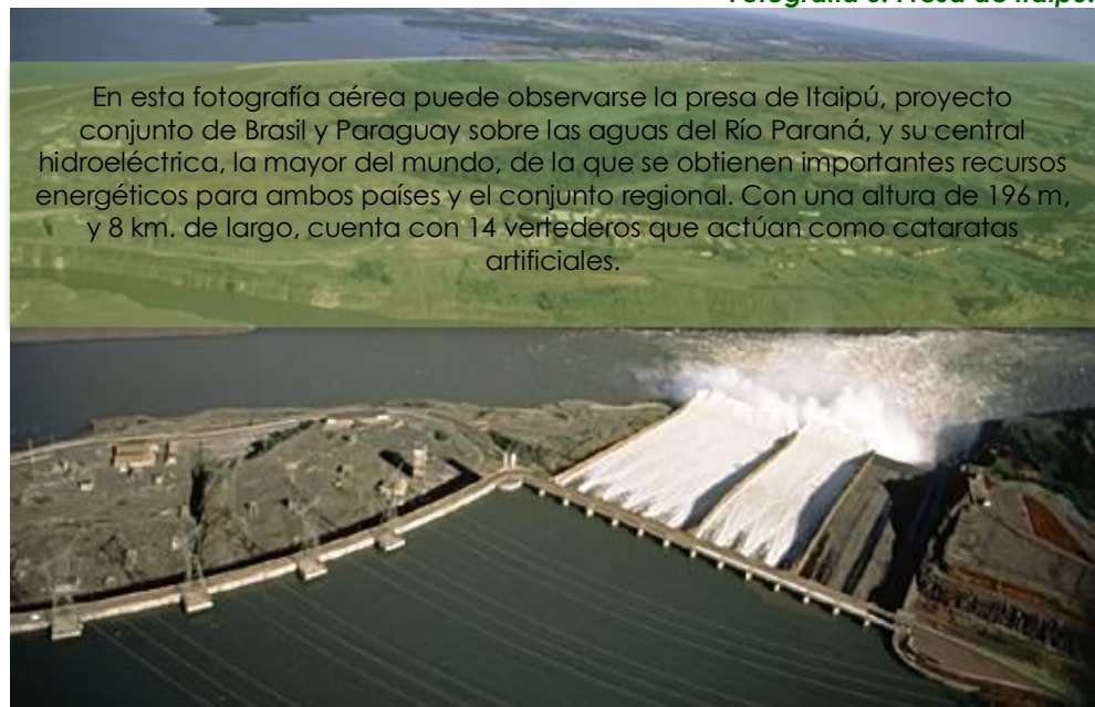
Fotografía 3. Presa de Itaipú.
