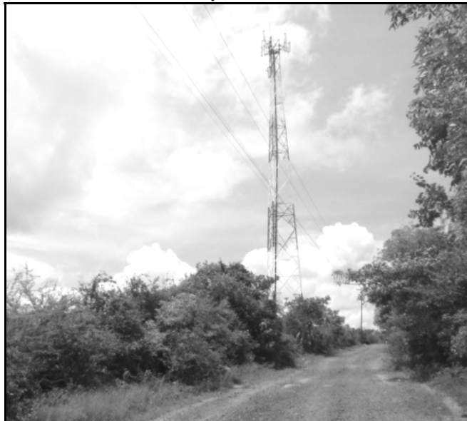
TORRE DE TELEFONÍA MOVIL: CLARO NOR-ORIENTE-CASCO URBANO Fotografía No. 25 11
