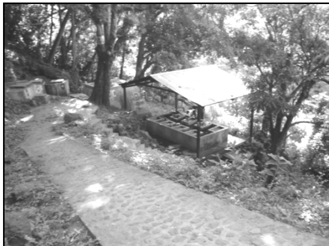
TANQUES DE AGUA Y LAVADEROS ORIENTE-CASCO URBANO Fotografía No. 21 8
