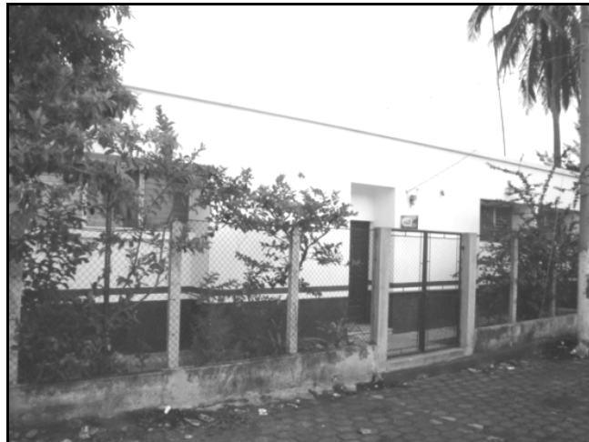
EDIFICIO DE CORREOS, CENTRO-CASCO URBANO Fotografía No. 23 14
