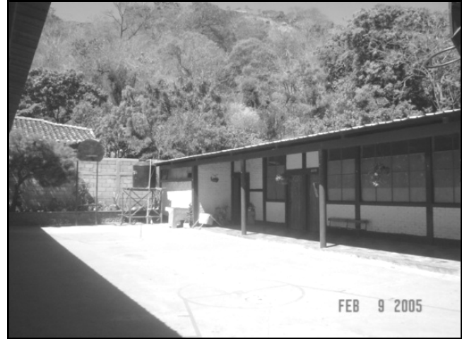
CANCHA DE BALONCESTO, ESCUELA PRIMARIA OCCIDENTE-CASCO URBANO Fotografía No. 31 15
