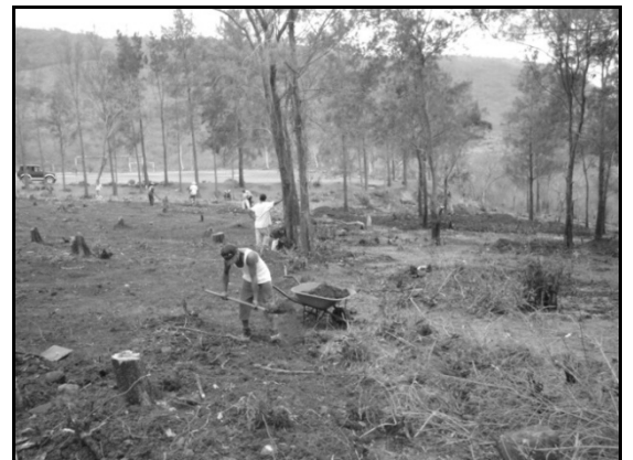
LIMPIEZA DE TERRENO PARA FUTURA CONSTRUCCIÓN Nor Oriente del Casco Urbano – Zapotitlán Fotografía No. 37
