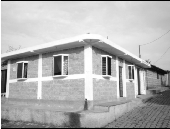
VIVIENDA ORIENTE-CASCO URBANO Fotografía No. 20 6
