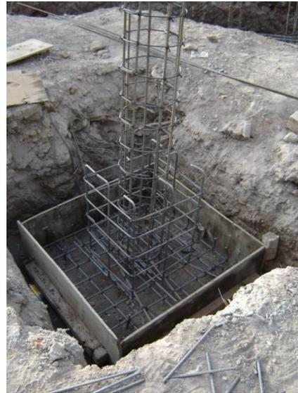
**Fotografía 4 Zapata de concreto armado**
