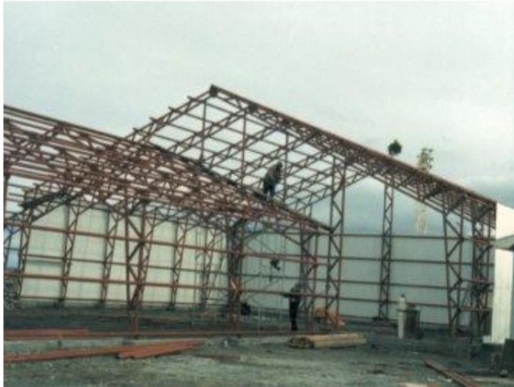
**Fotografía 7 Estructurado metálico para cubiertas**
