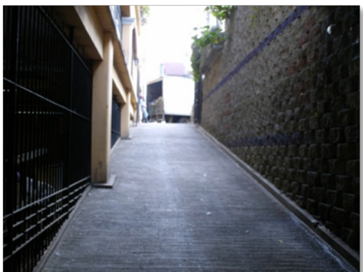
RAMPA DEL ÁREA CARGA Y DESCARGA FUENTE ELABORACIÓN PROPIA
