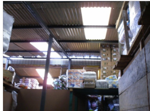
INTERIOR TECHO METÁLICO FUENTE. PROPIA
