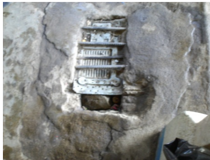
Fotografía No. 12 Drenaje
