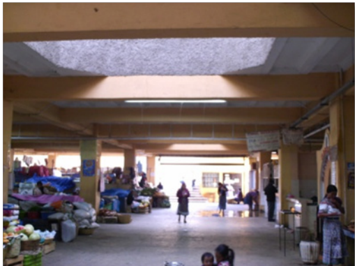
ILUMINACIÓN NATURAL DEFORMA CENITAL FUENTE PROPIA
