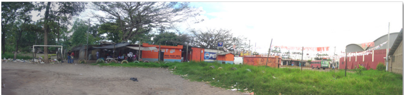
Fotografía No 07 Mercado y estacionamiento de buses urbanos Fuente propia.
