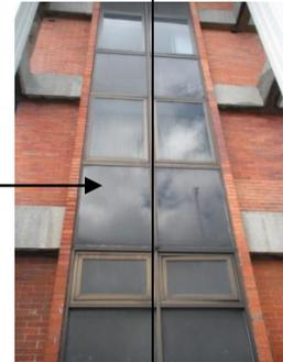
El edificio posee una *fachada libre*, ya que sus muros no son de carga, y la estructura, por medio de vigas y columnas de concreto, es la que define su forma. Incluso el muro de ladrillo que conforma sus fachadas está retirado de su estructura.
