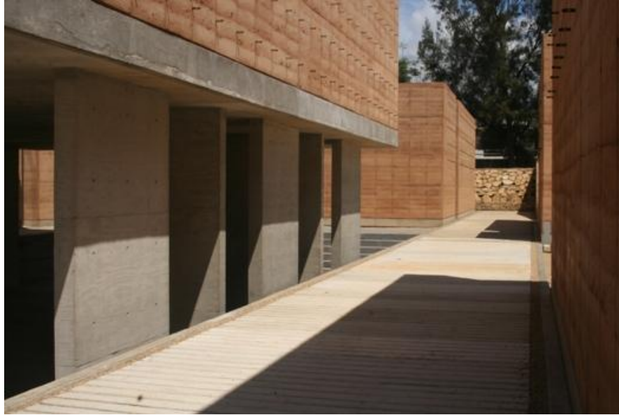
Escuela de Artes Plástica (Arq. Mauricio Rocha) 23
