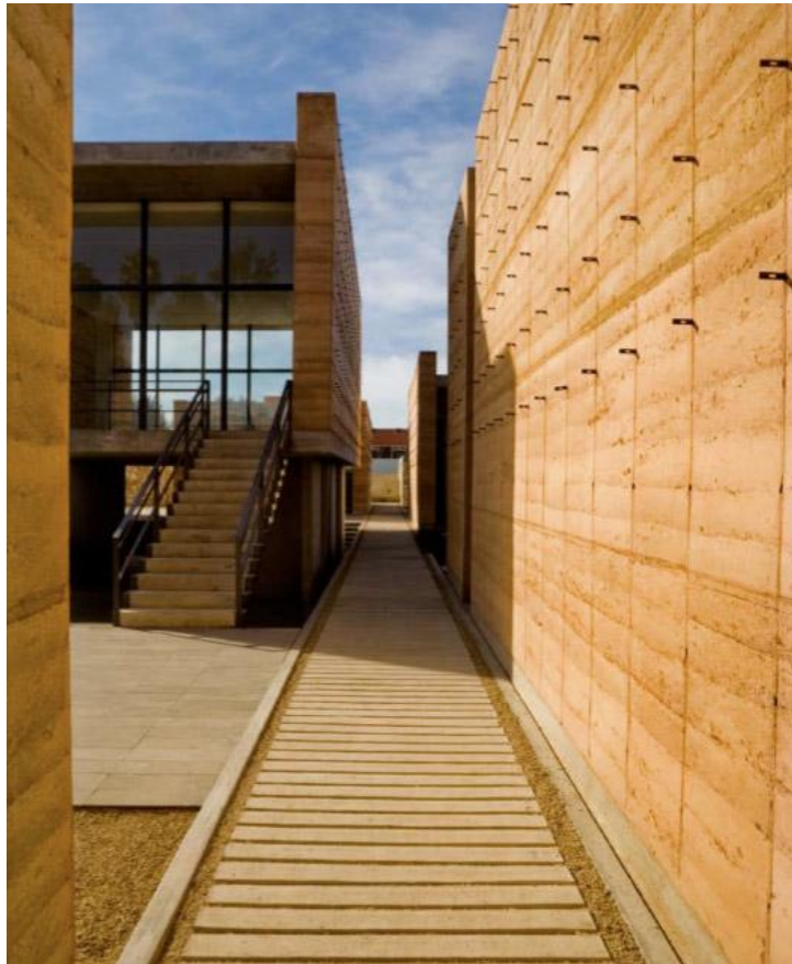
Escuela de Artes Plástica (Arq. Mauricio Rocha) 24
