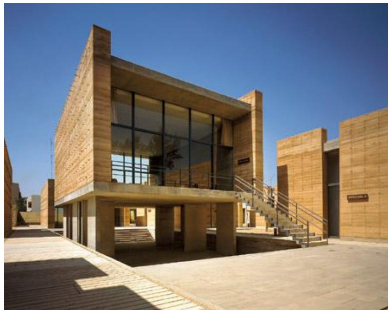
Escuela de Artes Plástica (Arq. Mauricio Rocha) 22
